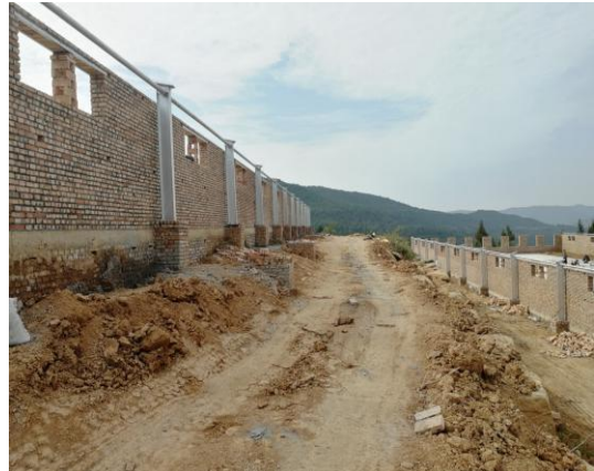
图 2.1-9 场内道路现状
