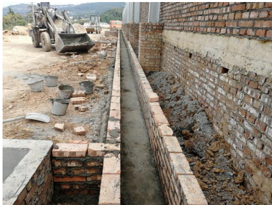
图 3.2-1 场地内排水沟现状
