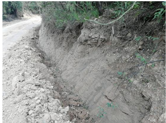
图 3.2-2 进场道路边沟现状
