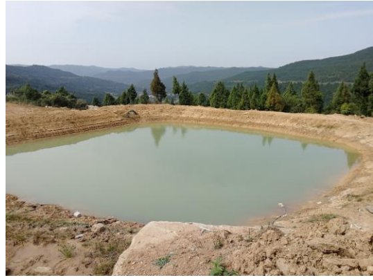
图 2.1-7 沉淀池建设现状
