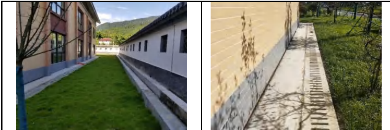
图 3.5-1 浆砌砖排水沟及浆砌砖盖板沟
