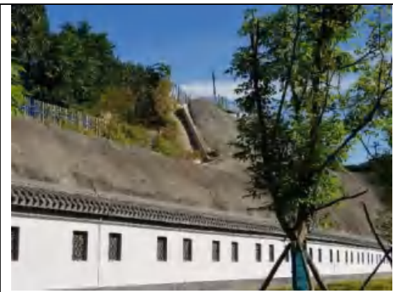
图 3.5-5 完工后边坡截水沟
