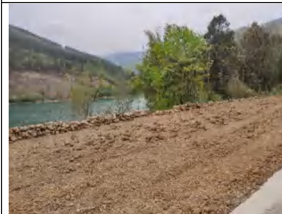
土地整治工程（管线工程区）
