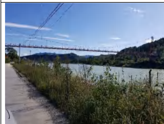
植被建设工程（管线工程区）
