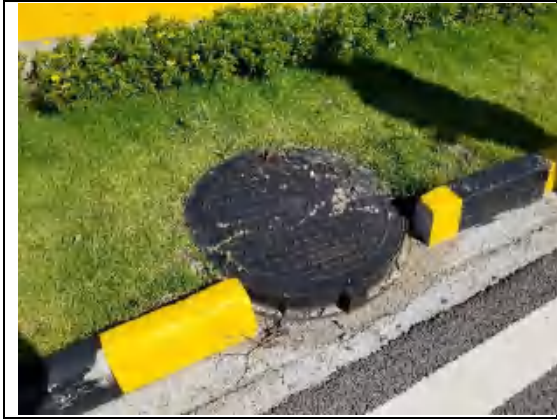
植被建设工程（净水厂区）
