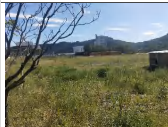
植被建设工程（净水厂区）
