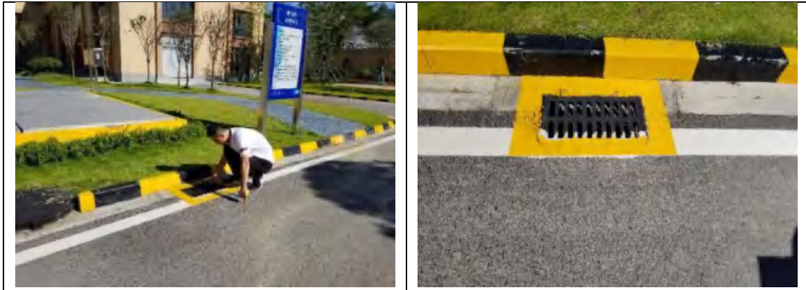
图 3.5-8 广场道路中的雨水口
