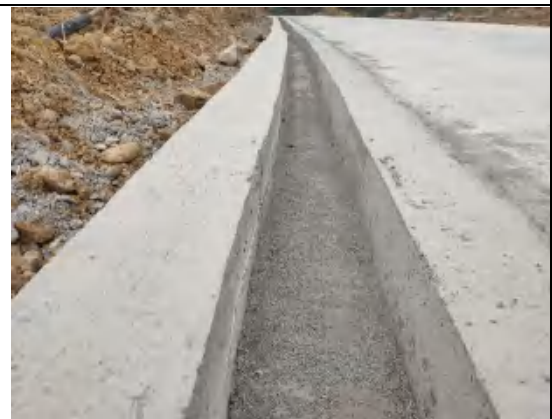
防洪排导工程（管线工程区）
