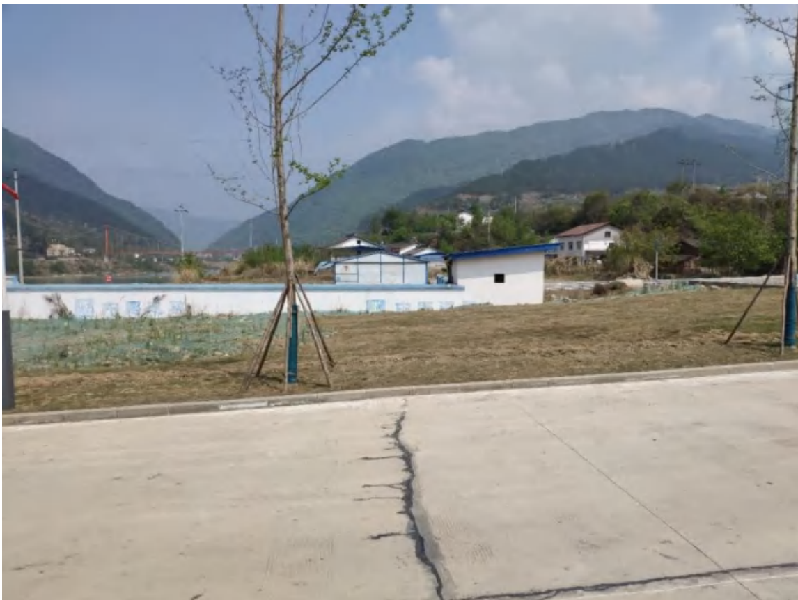
图 1.1-10 净水厂施工临时设施（现已拆除）
