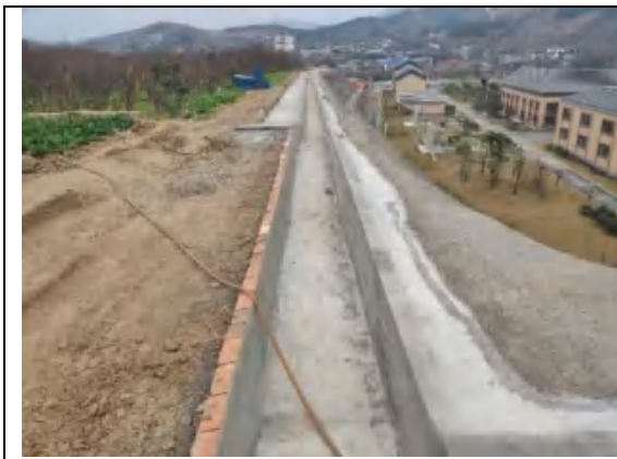
图 3.5-4 施工过程中截水沟
