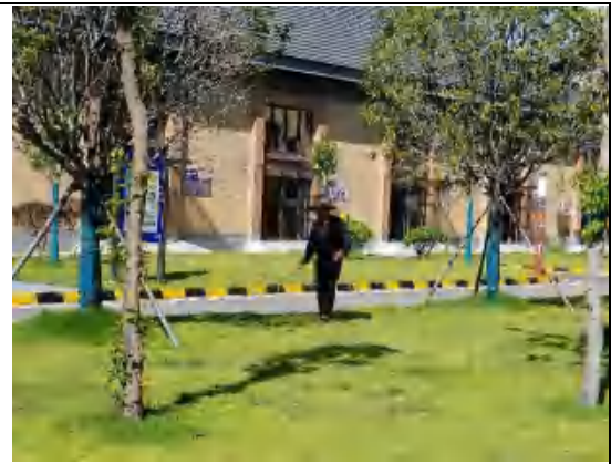
植被建设工程（净水厂区）
