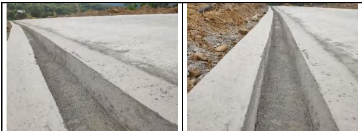
图 4.2-5 防洪排导工程现场核查情况
