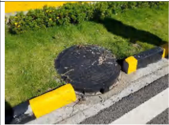
图 3.5-7 广场道路中的集水井
