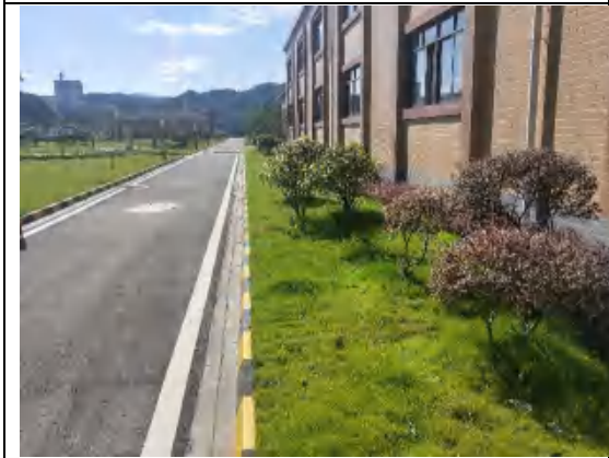
植被建设工程（净水厂区）
