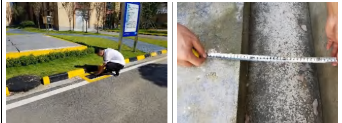
图 4.2-3 防洪排导工程现场核查情况
