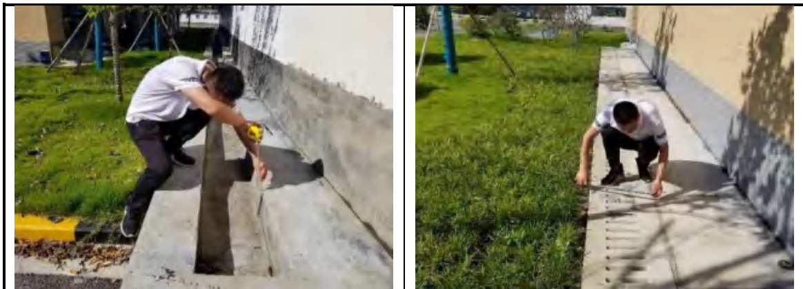
图 4.2-2 防洪排导工程现场核查情况
