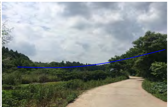
线路工程沿线现场照片
