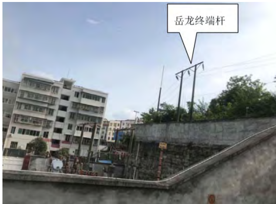
项目线路沿线现场照片
