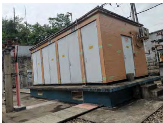
变电站站外道路侧现场照片
