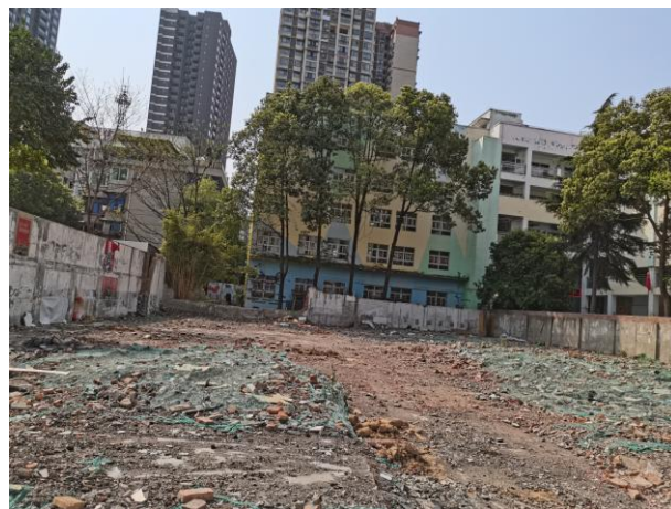
项目区场地内现状
