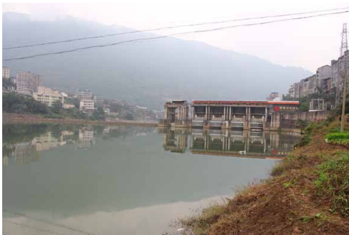
试运行中的东溪水电站枢纽（上）
