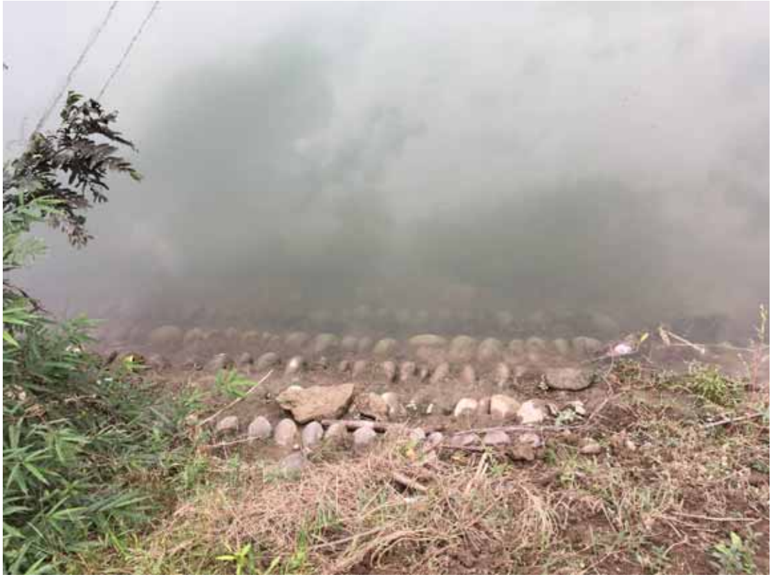
实施的干砌块（卵）石挡渣墙现状（上、下、2018.10）
