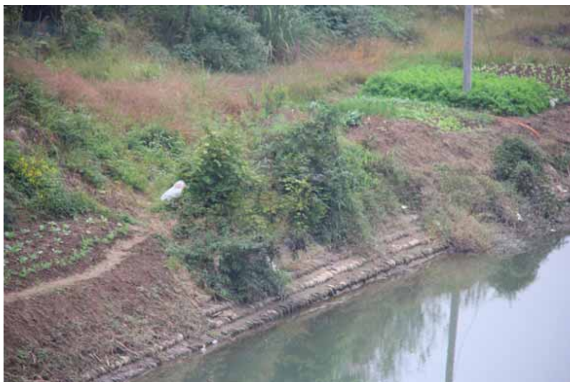
弃渣场区实施的干砌块(卵)石拦挡措施现状(上)
