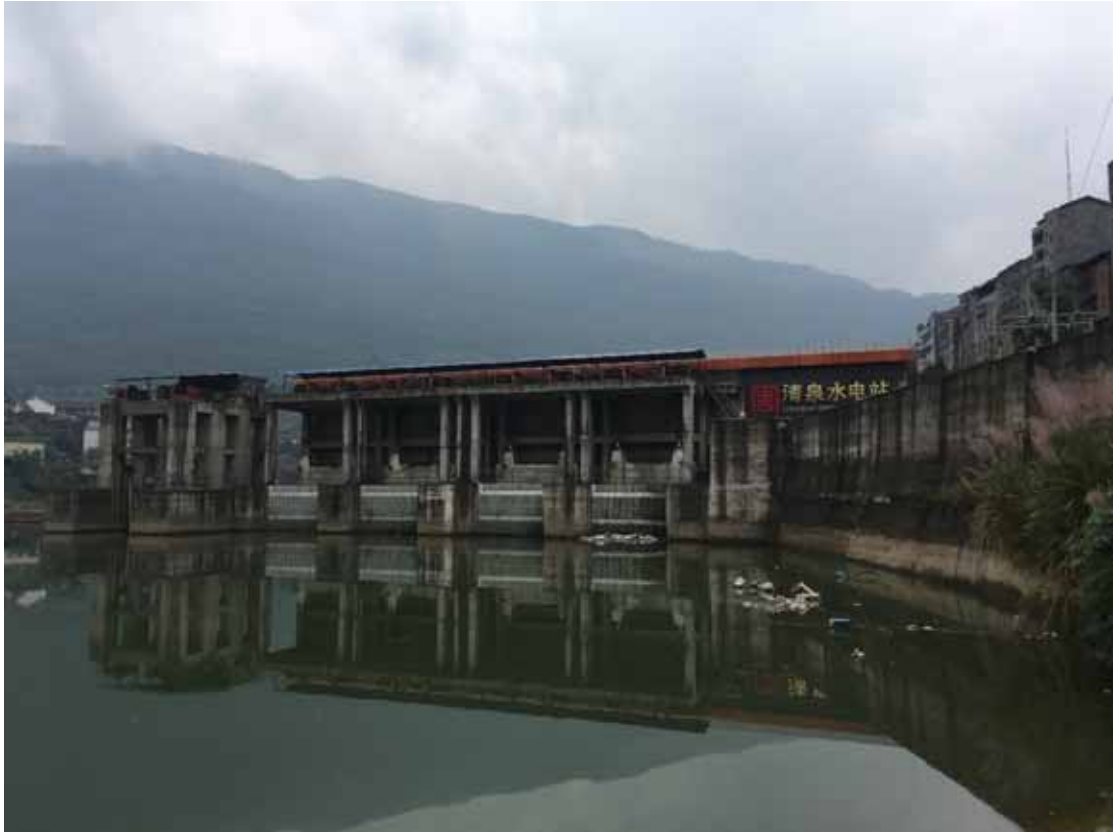
主体工程上游面（上）及大坝和溢流坝段（下）状况（2018.10）
