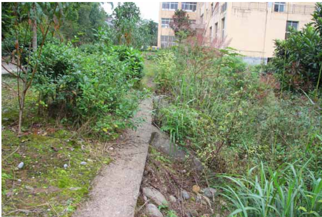
主体工程区实施的框格护坡、种草植树效果（上、2018.10）
