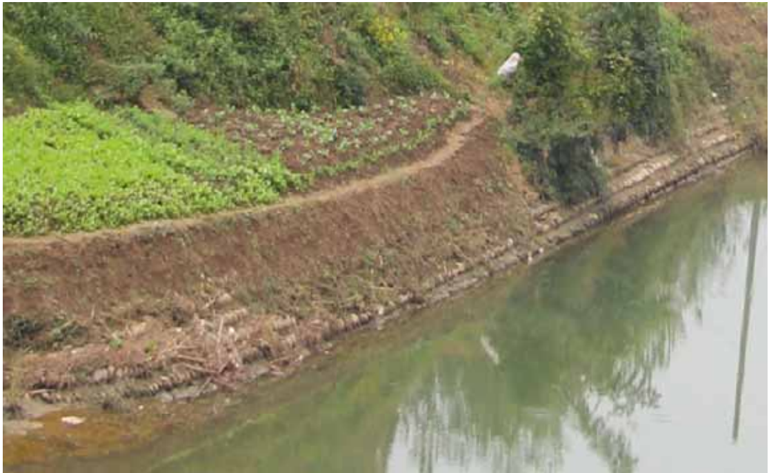
实施的干砌块（卵）石挡渣墙现状（上、下、2018.10）
