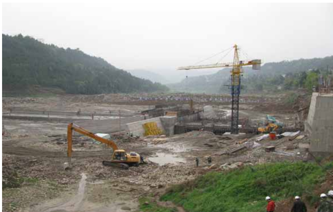
电站枢纽施工现场（上、2010.4）
