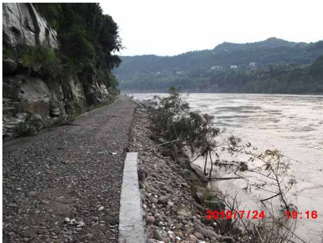
施工期间使用中的道路（上、2010.7）
