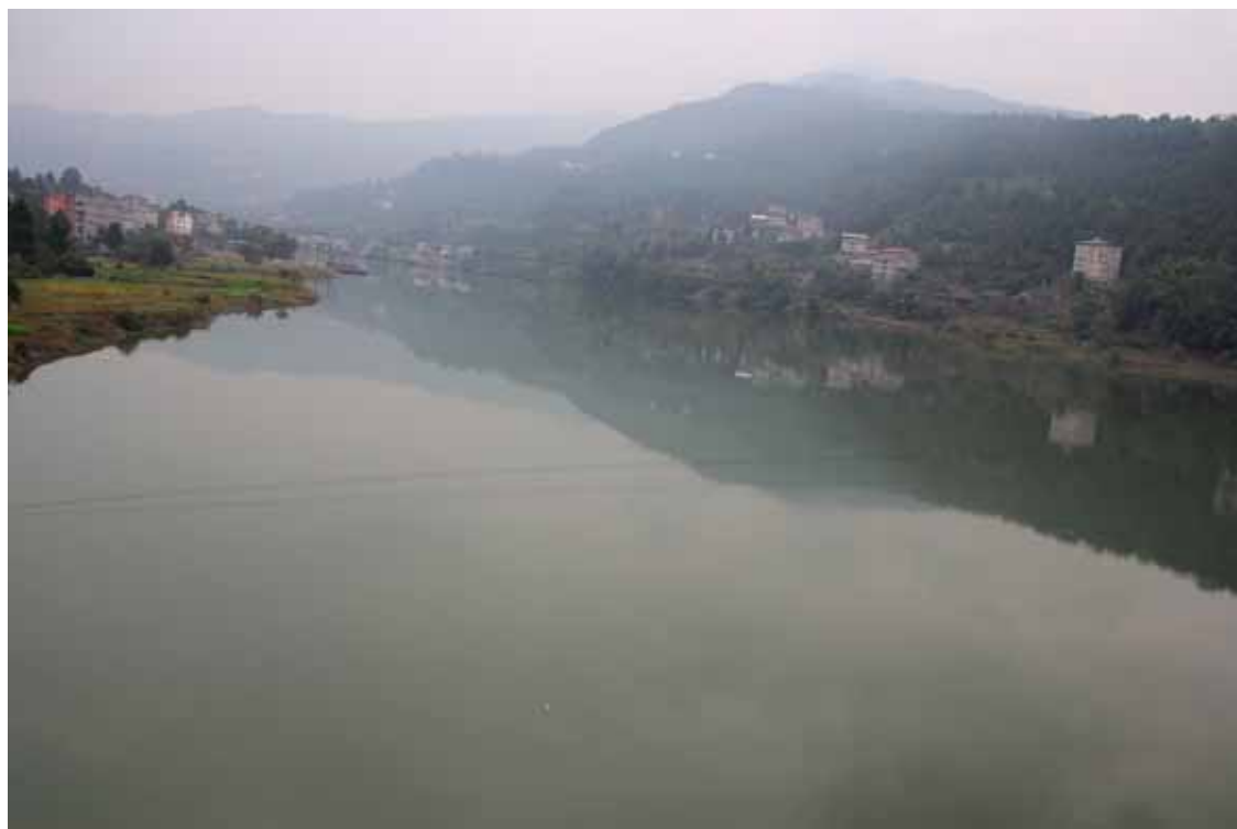
淹没在水下的取料场现状（上图靠右边处）
