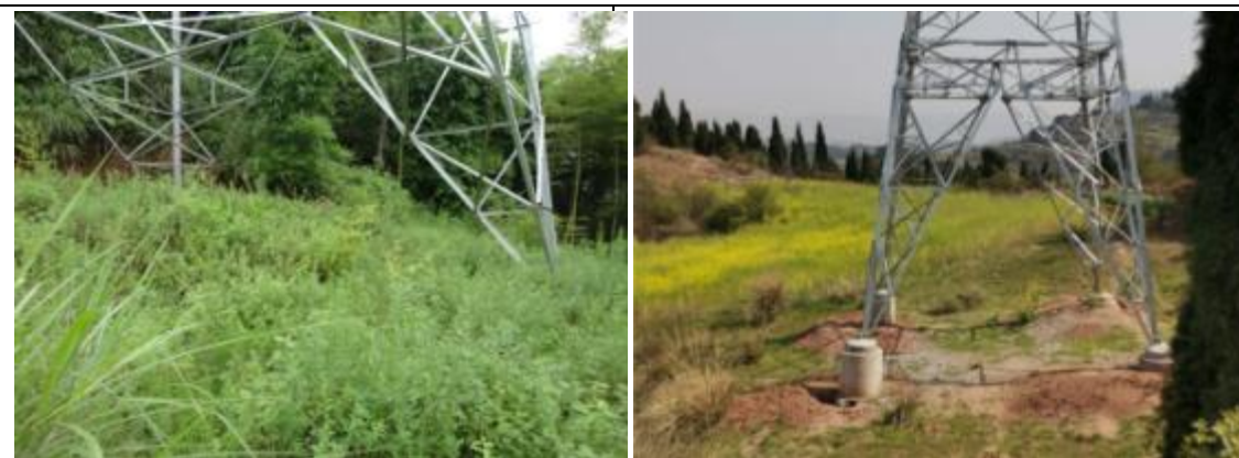
塔基区及塔基施工临时占地植被生长情况
