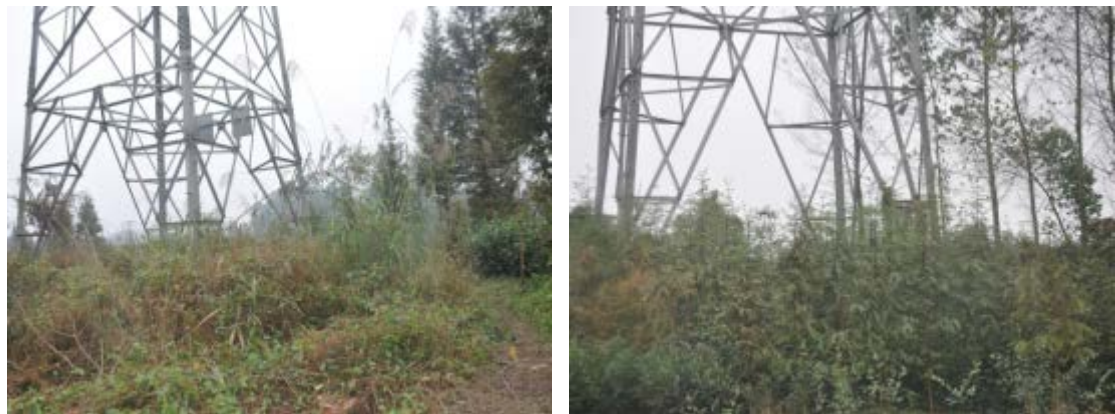
图 3.5-3 塔基区及塔基施工临时占地植被生长情况
