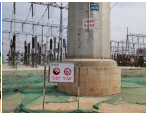
场地临时遮盖（施工期）
