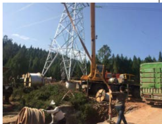
铁塔架设（施工期）
