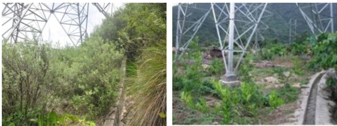
图 3.5-1 塔基排水设施
