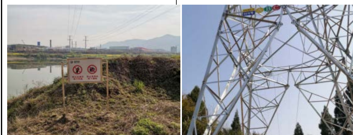
塔基区建设现状
