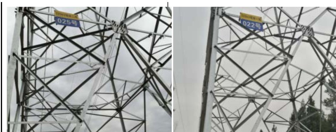
塔基区建设现状
