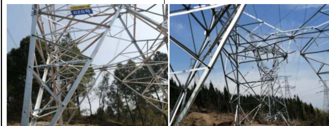
塔基区建设现状
