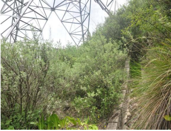
塔基区排水沟
