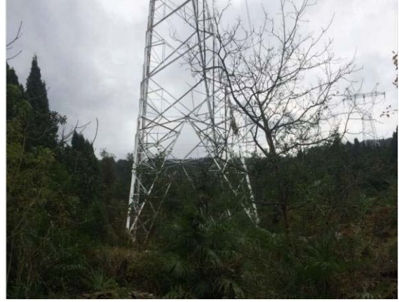
塔基区建设现状
