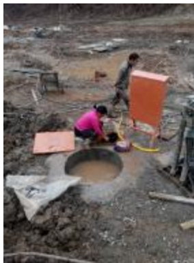
施工中的集水井
