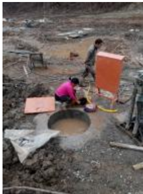
施工中的集水井
