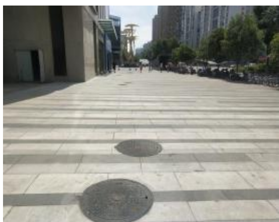
排水设施现场照片（3）
