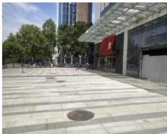
排水设施现场照片（4）
