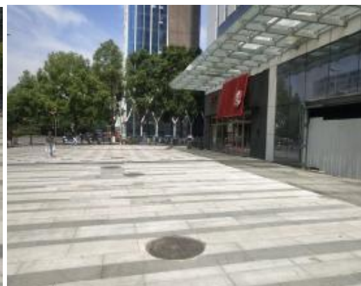
排水设施现场照片（4）
