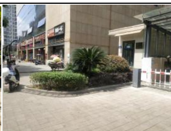
植物措施现场照片 (2)
