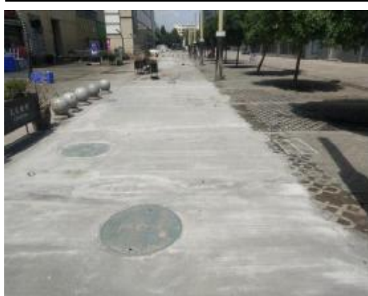
排水设施现场照片（1）
