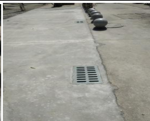
排水设施现场照片（2）
