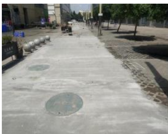
排水设施现场照片（1）
