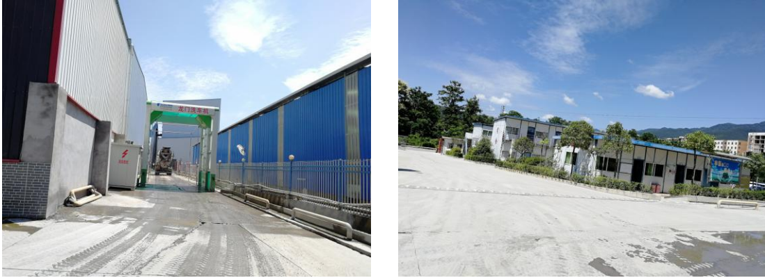
图 2.1-10 道路硬化区现状
