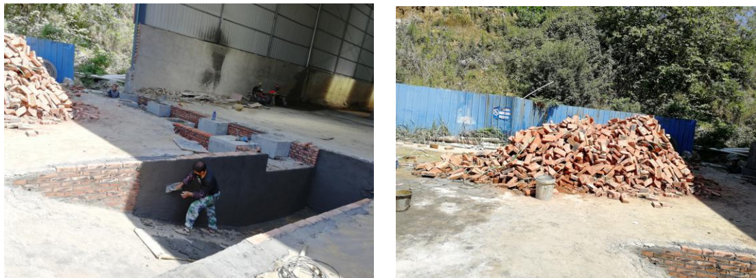
图 2.1-5 砂浆搅拌区建设现状
