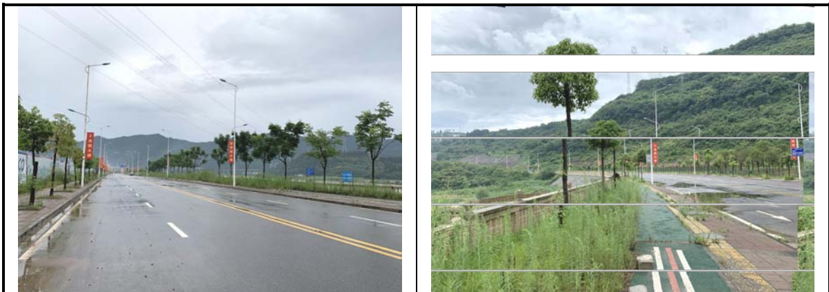
图 3-1 滨江西路（袁家坝至土基坝）道路项目现状
