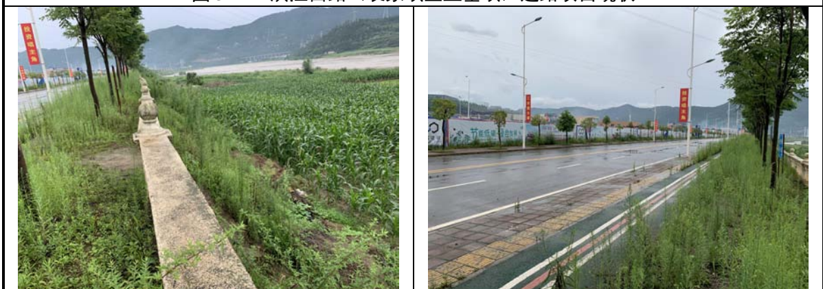
插图 3-2 滨江西路（袁家坝至土基坝）道路项目现状
