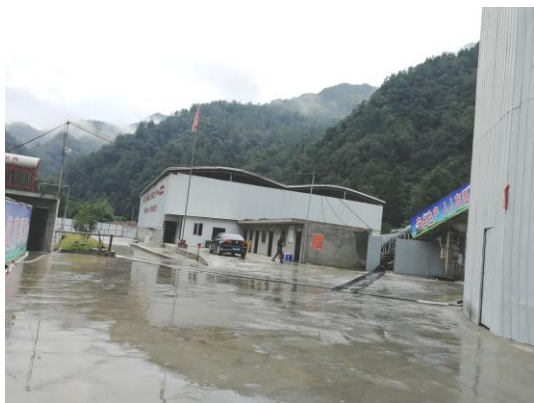
图 2.1-8 道路及附属工程现状
