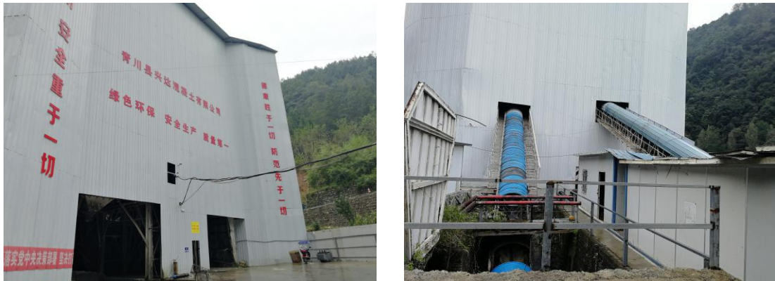
图 2.1-6 生产搅拌区现状
