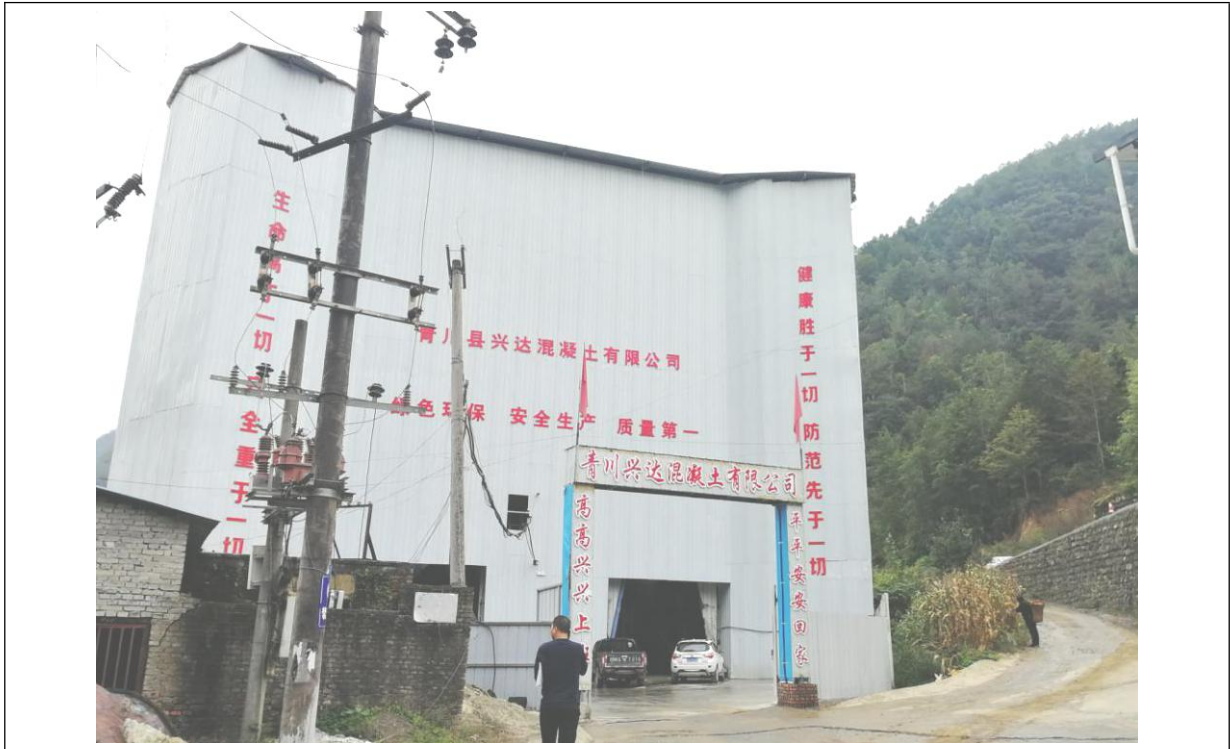
项目建设现状
