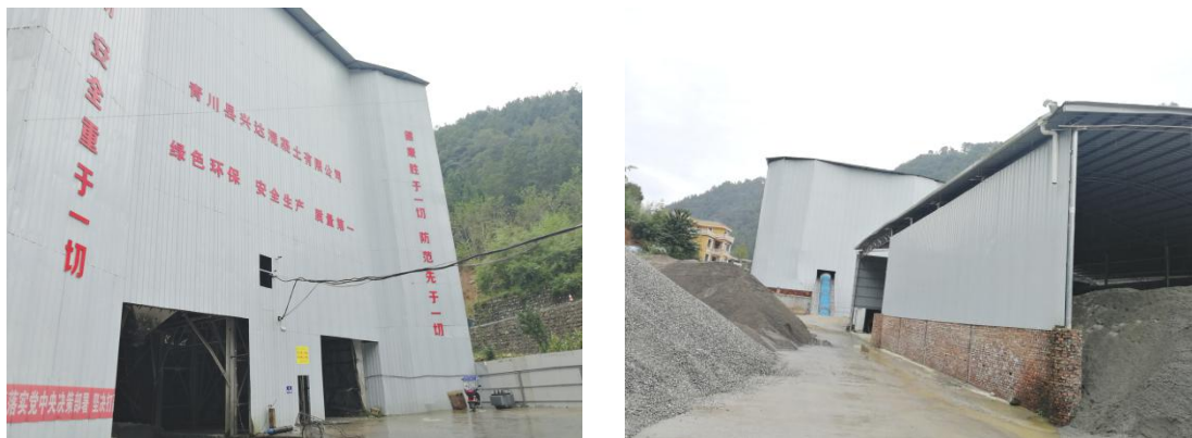
图 2.1-2 工程建设现状
