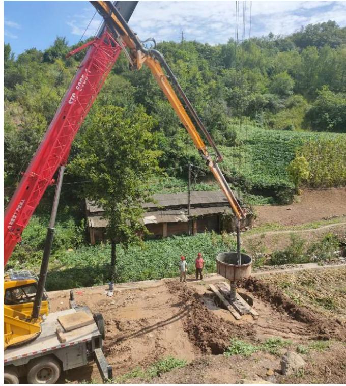
项目施工现状
