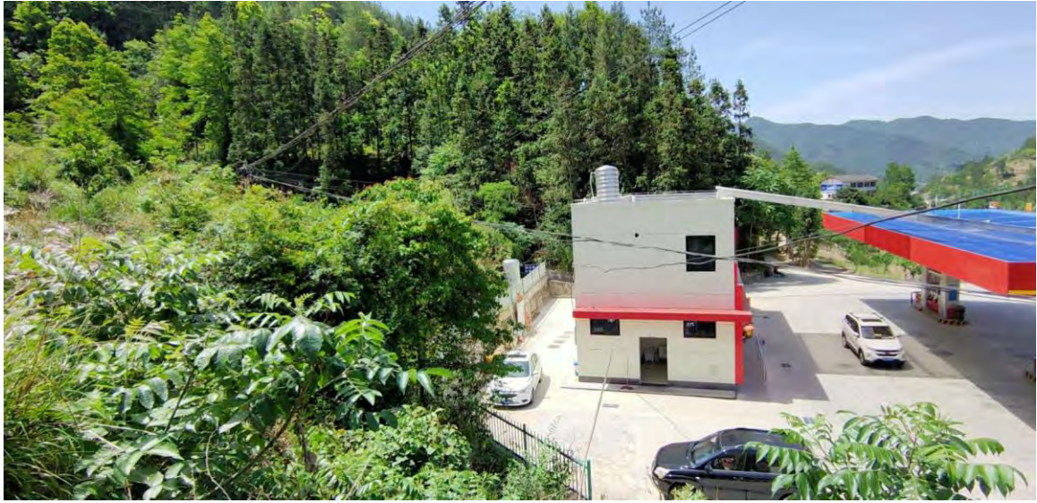
项目现状照片
