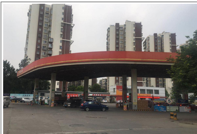
已建加油站（罩棚）现状
