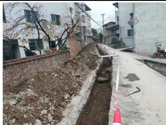
优化施工工艺后沟槽开挖（第二部分区域管道沟槽）
