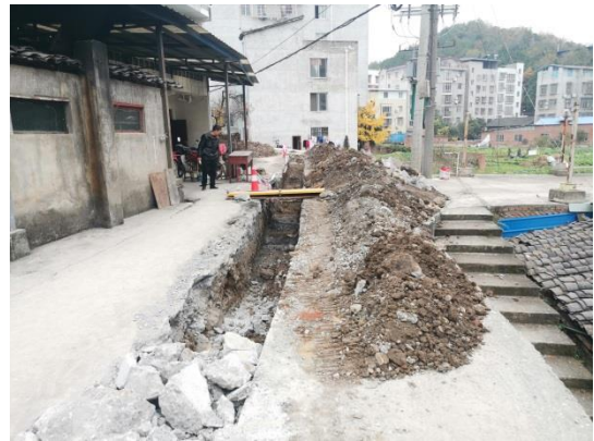
沟槽开挖施工现场
