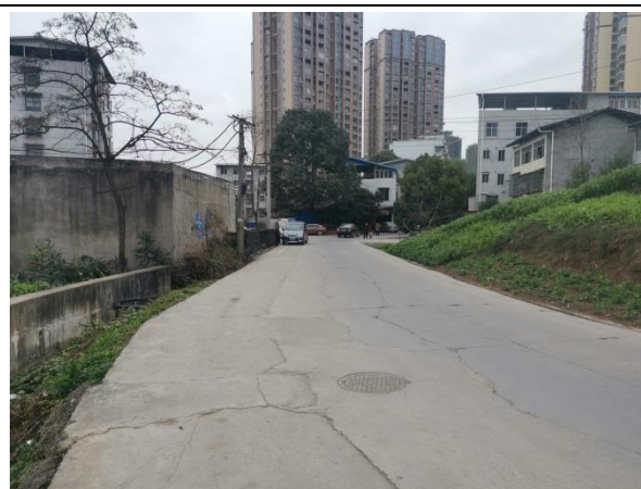
A 线、B 线、C 线、D 线、E 线、K 线未开工
