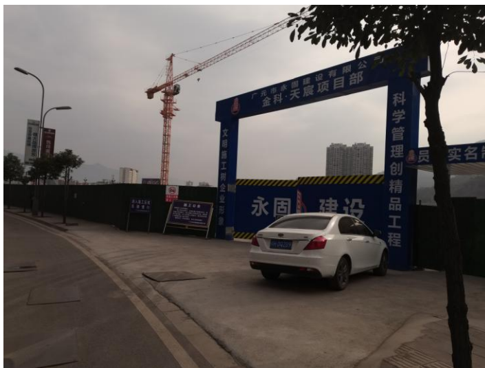
项目区西北外侧紧邻市政道路
