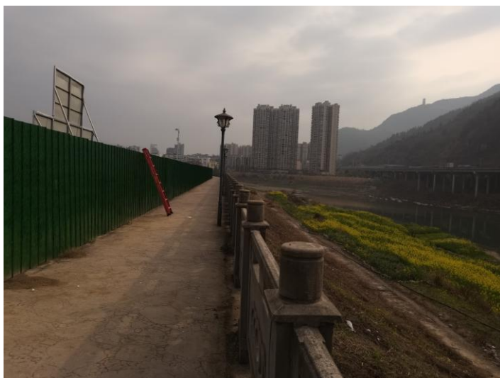
项目区南侧紧靠东河河堤
