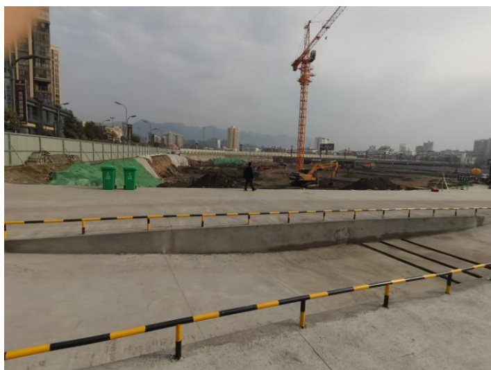
场地内施工现状
