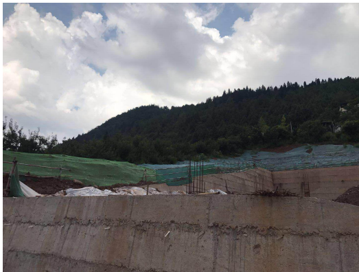
周边场地临时覆盖
