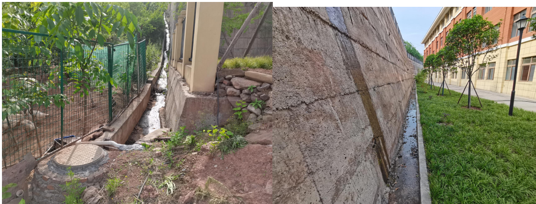
场地周边排水沟
