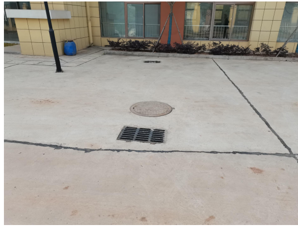
建筑物周边盖板排水沟
