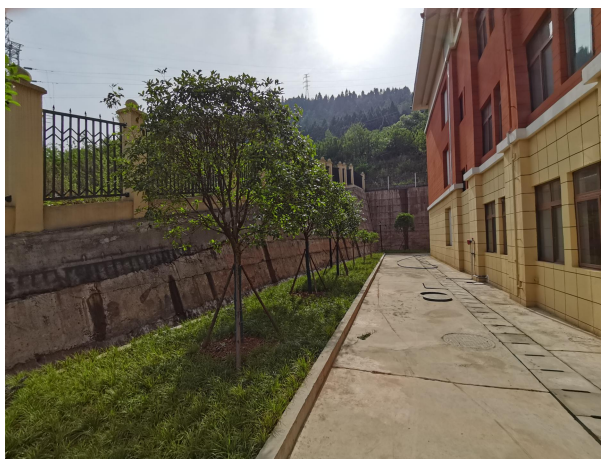
植物措施-草坪、乔木
