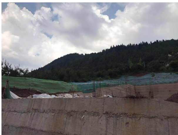
周边场地临时覆盖
