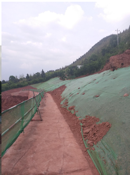
绿化区临时覆盖
