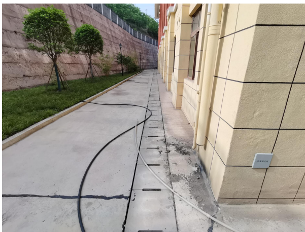
建筑物周边盖板排水沟
