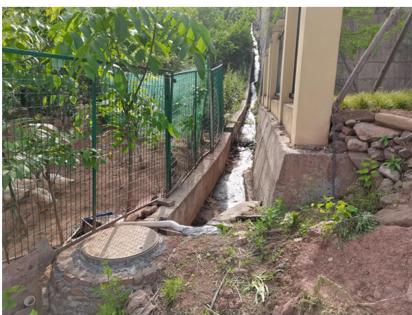
雨水口及雨水集水井
