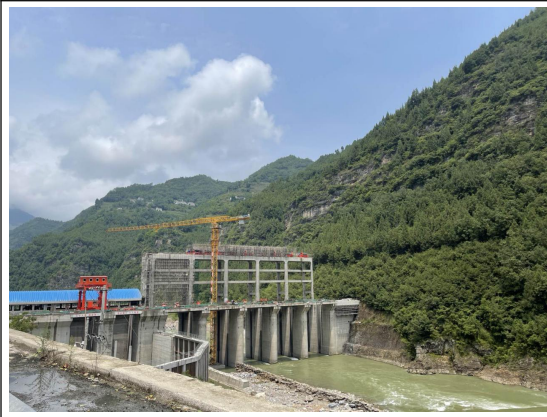
线路起点-八庙沟水电站
