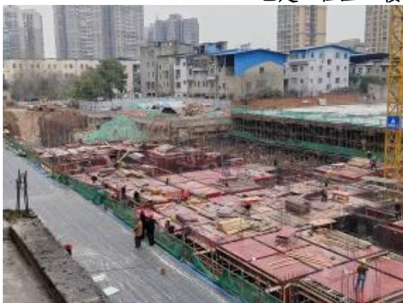
在建工程区实施的临时覆盖及施工出入口车辆清洗槽现状
