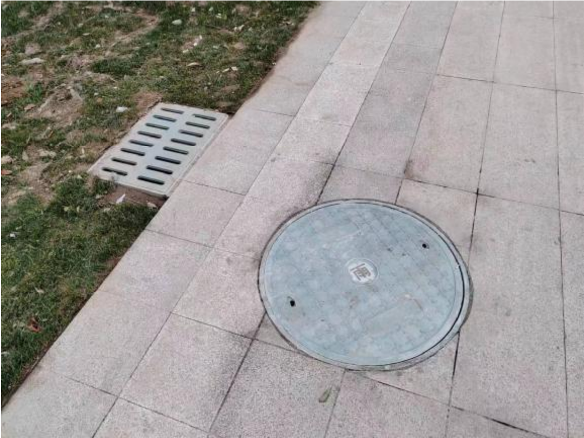
已建工程雨水管网现状
