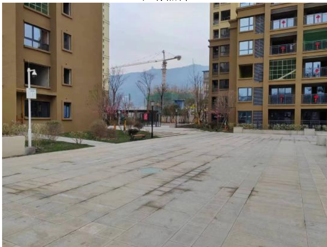
已建工程建构物及道路硬化现状 1
