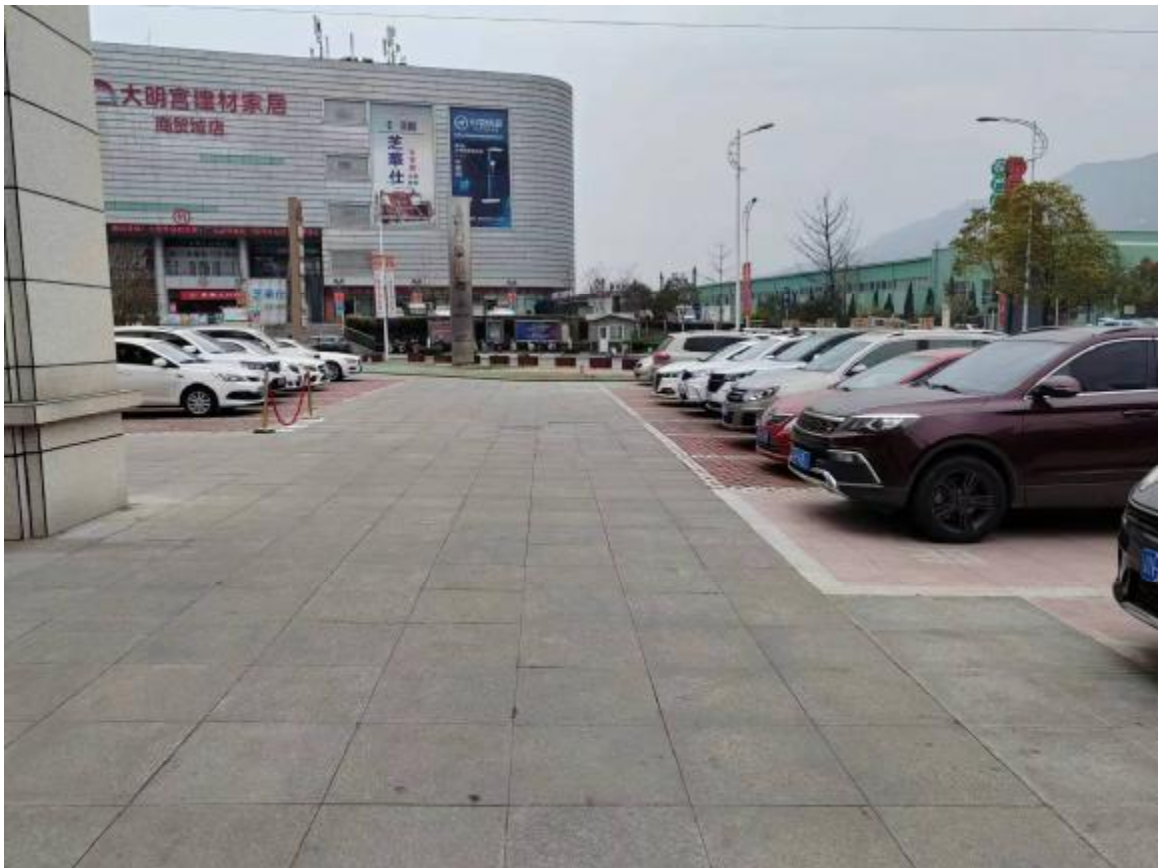
已建工程道路硬化现状
