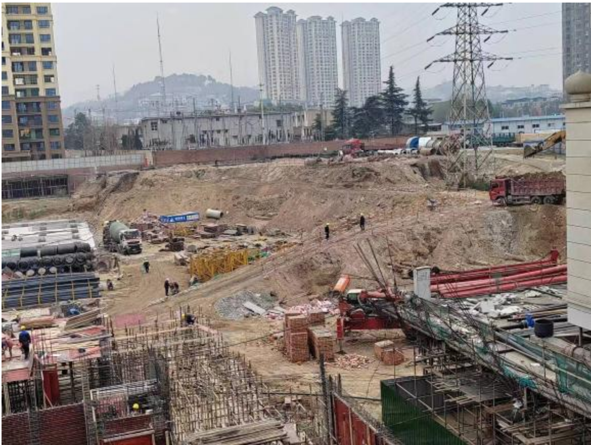
在建工程地下工程现状 1
