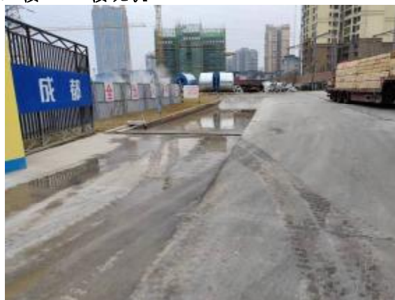
在建工程区实施的临时覆盖及施工出入口车辆清洗槽现状
