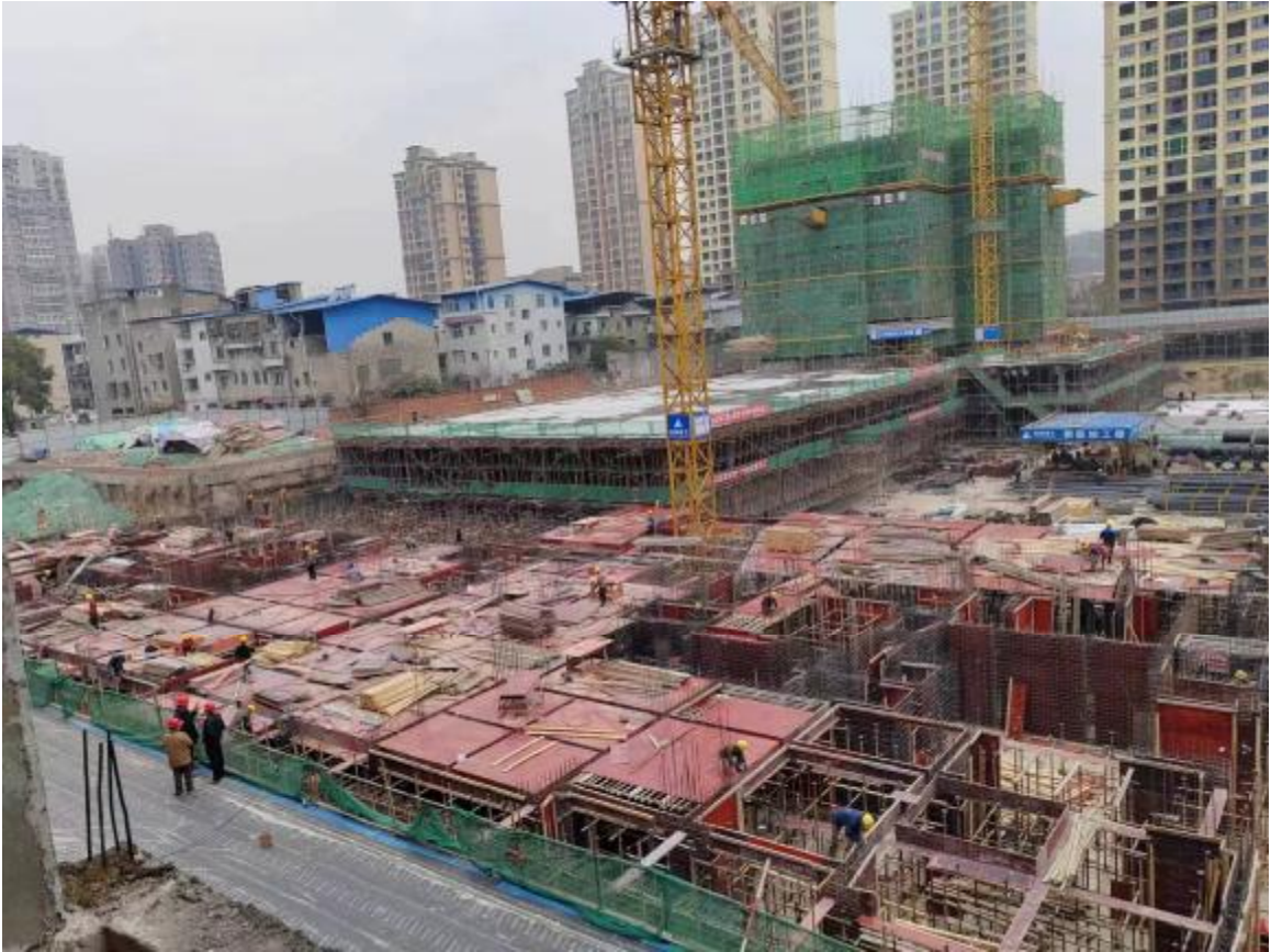
在建工程地下工程现状 2
