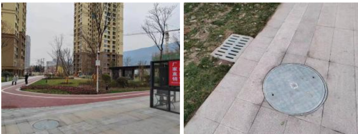
已建工程区 1#楼-3#楼、11#楼及场地内实施的景观绿化、雨水管网现状
