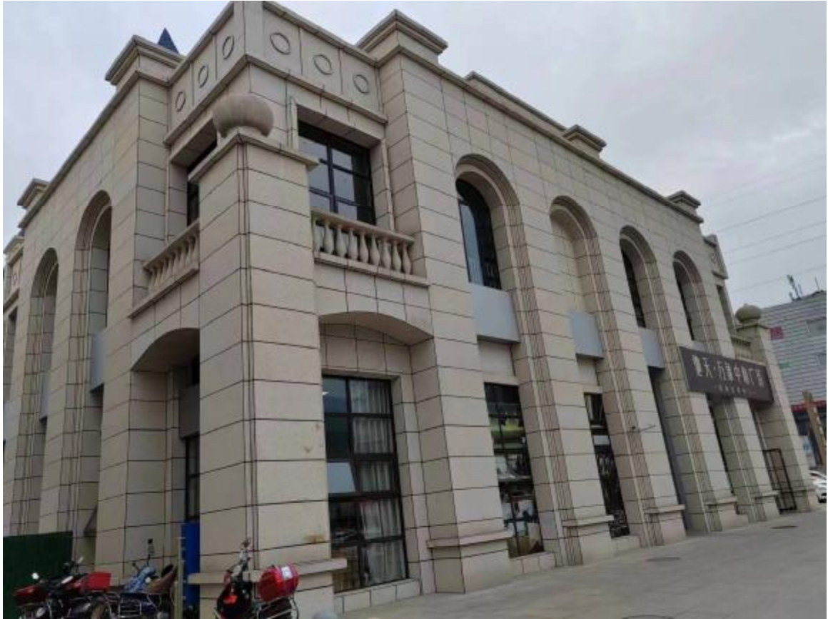
已建工程建构物现状
