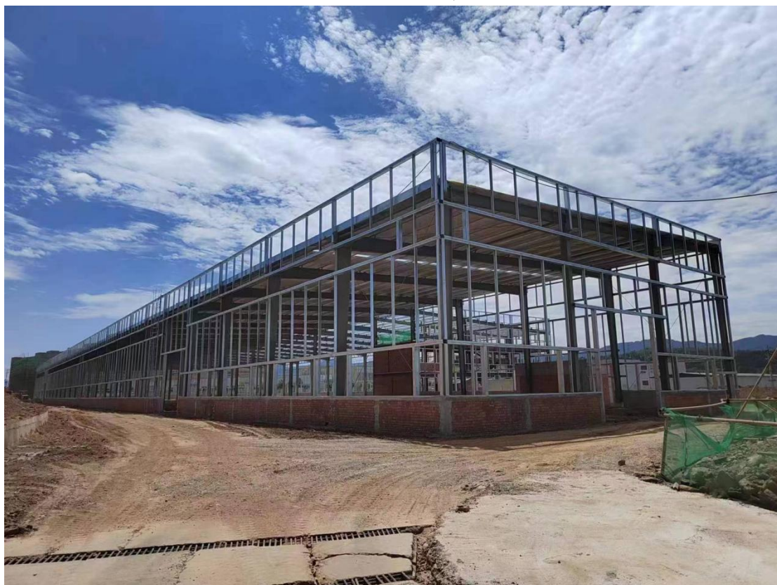
建构筑物工程建设现状 1
