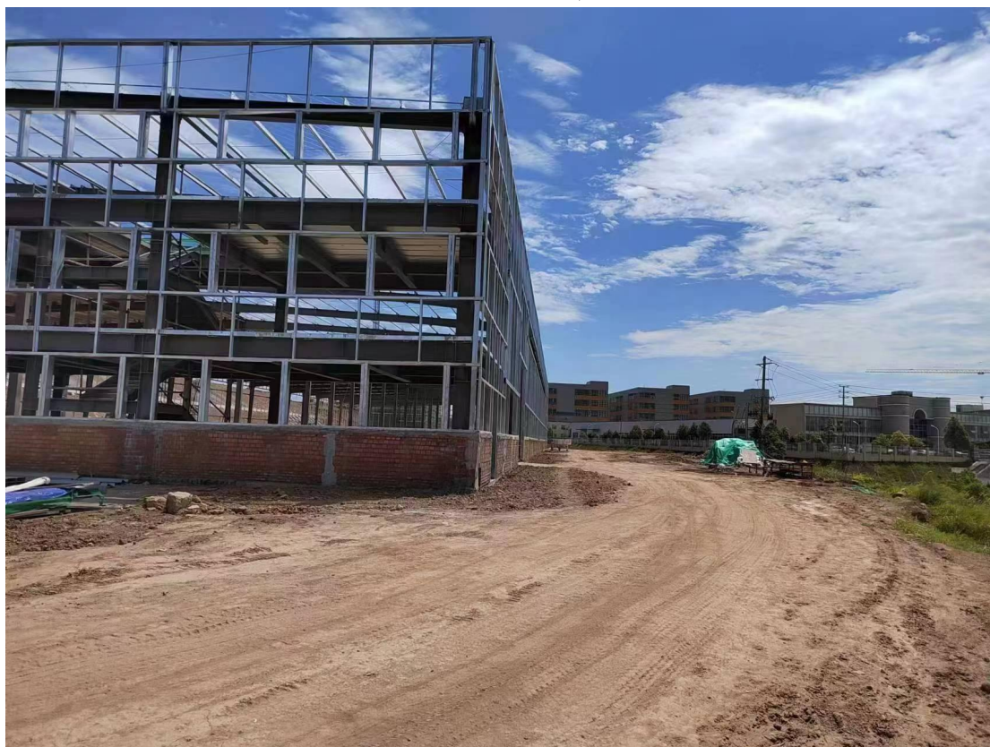
道路及硬化工程建设现状 1
