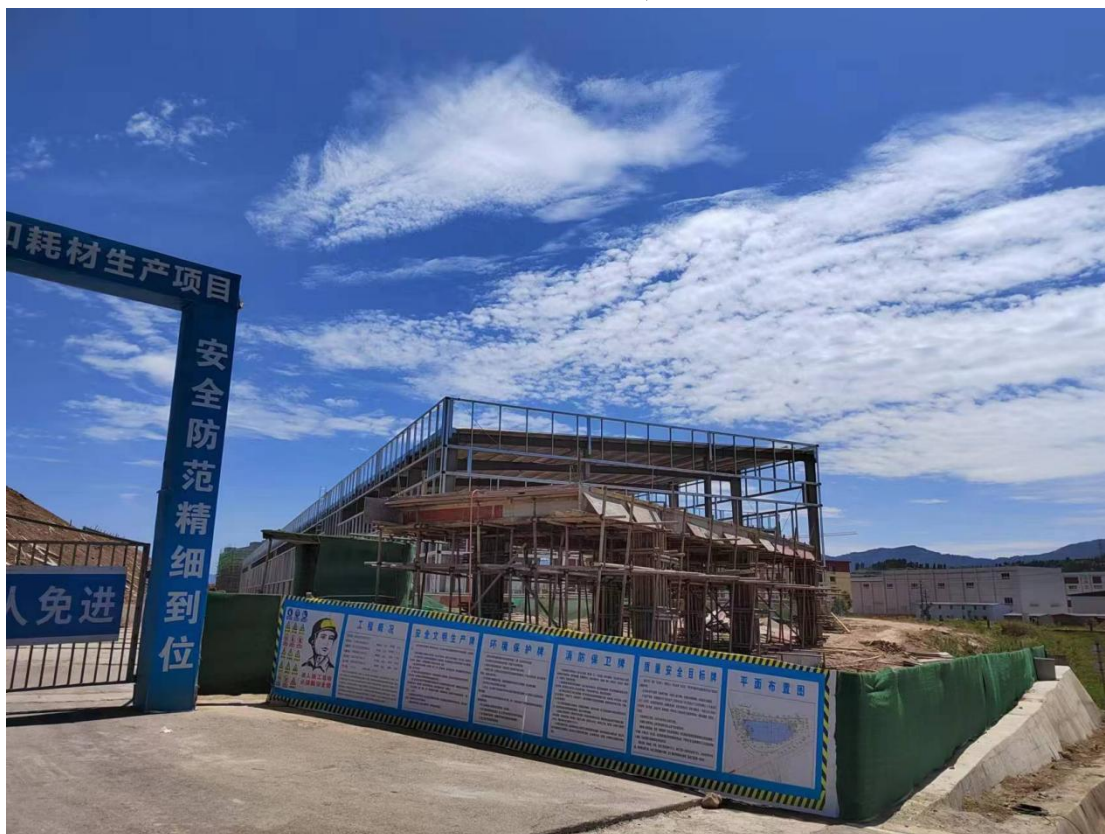
施工场地出入口
