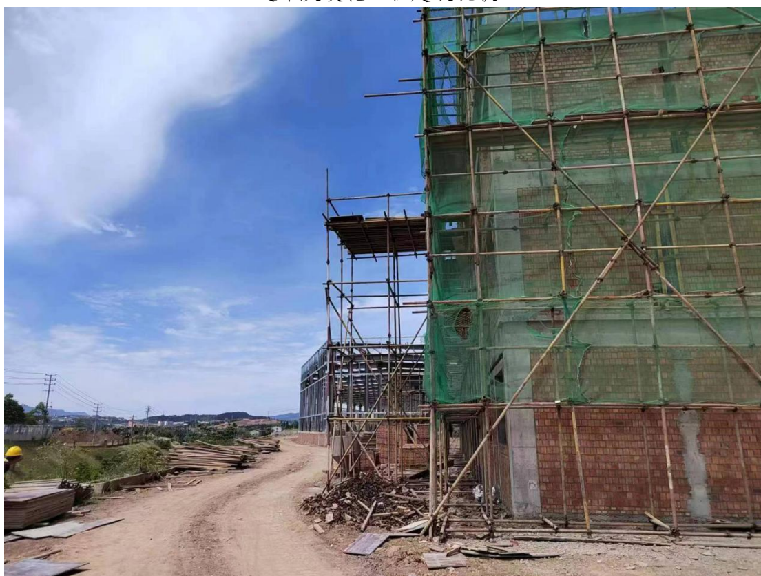
道路及硬化工程建设现状 2
