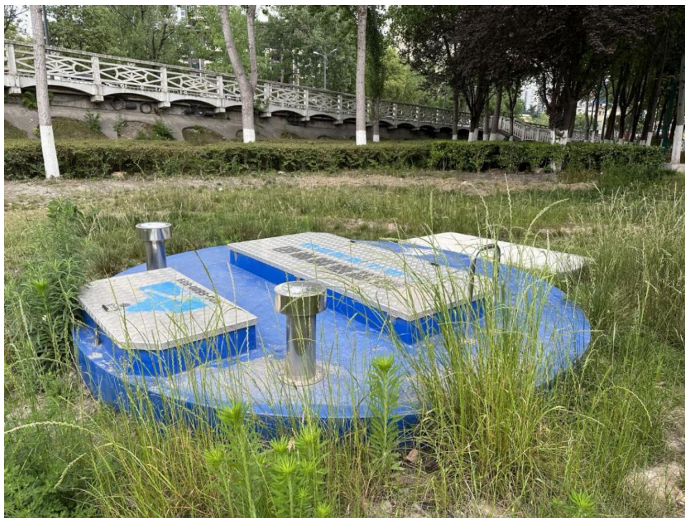
老鹰嘴大桥下穿点位新建泵站
