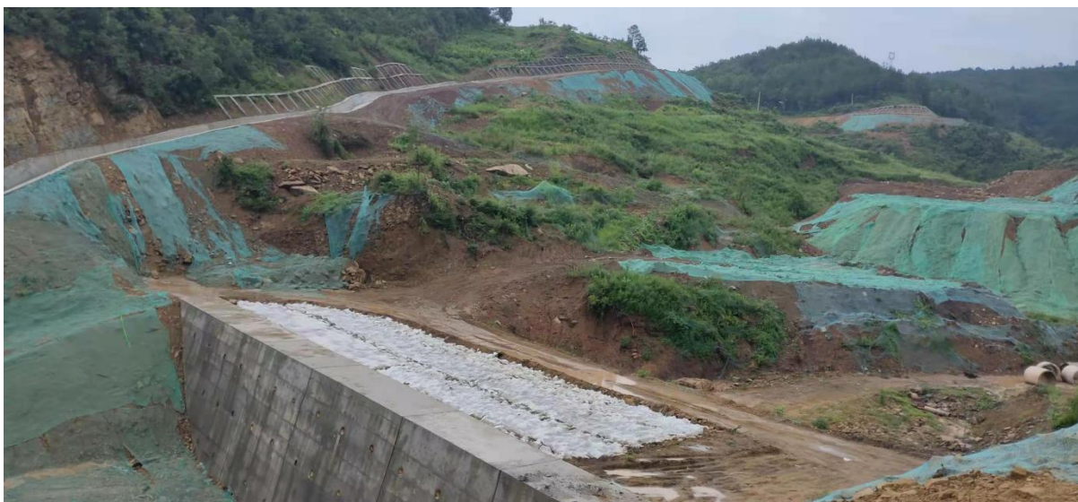
泡石沟弃渣场现状 2
