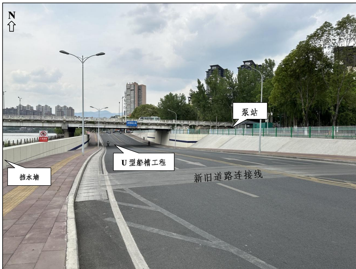
现状已修建老鹰嘴大桥下穿排水防涝点位
