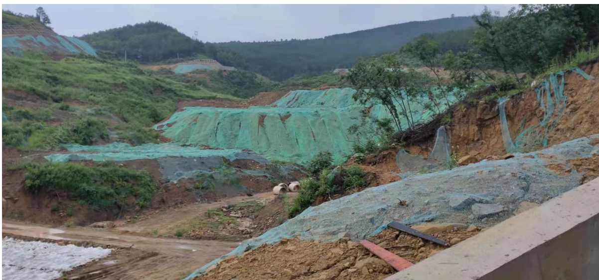
泡石沟弃渣场现状 1
