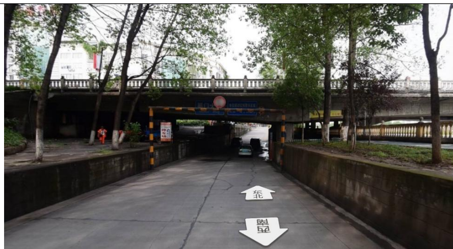
蜀门大桥下穿道路现状图
