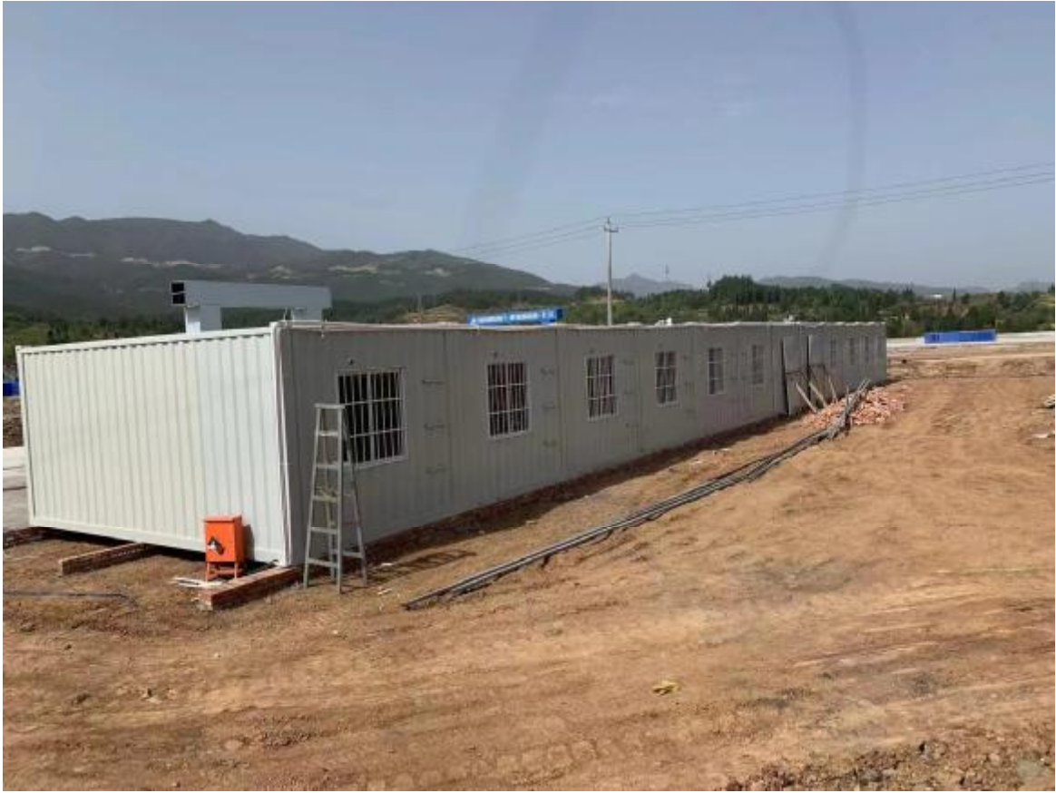
正在实施的施工场地现状 1
