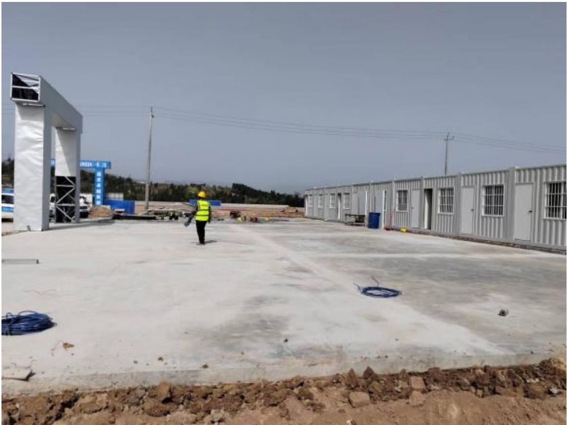
正在实施的施工场地现状 2
