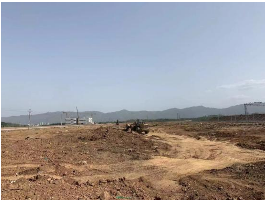
工程场地现状 2
