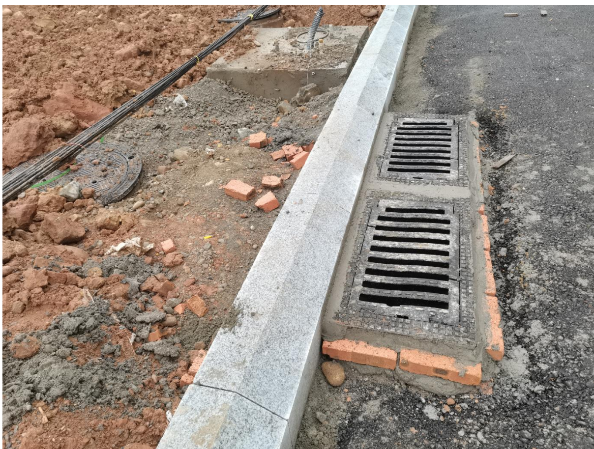
图 2.1-2 雨水口、雨水检查井、雨水管现状
