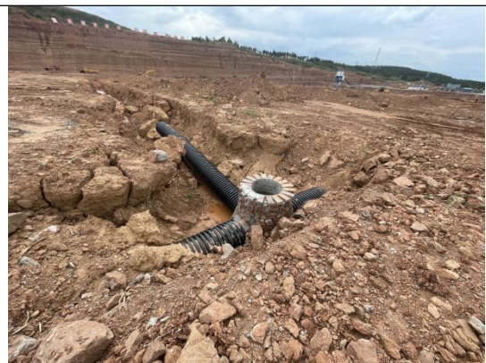
7、项目正在施工的雨水管网
