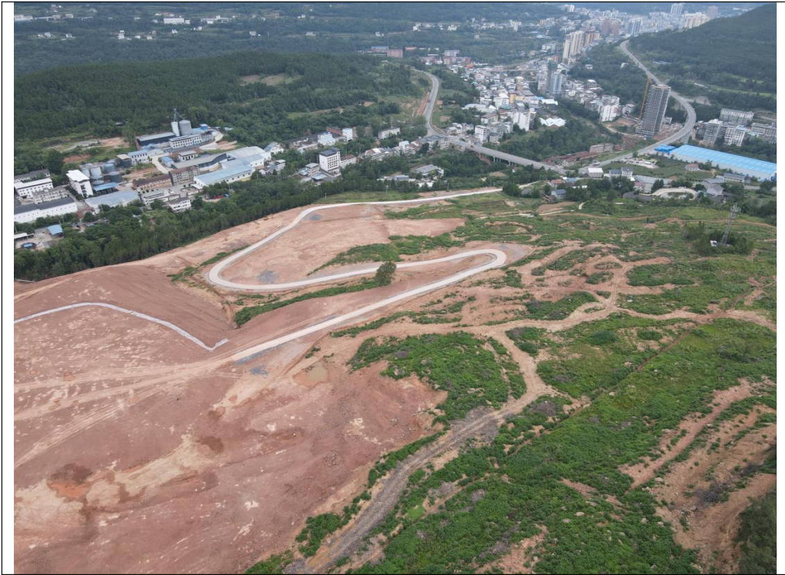
5、园区设置的临时施工便道
