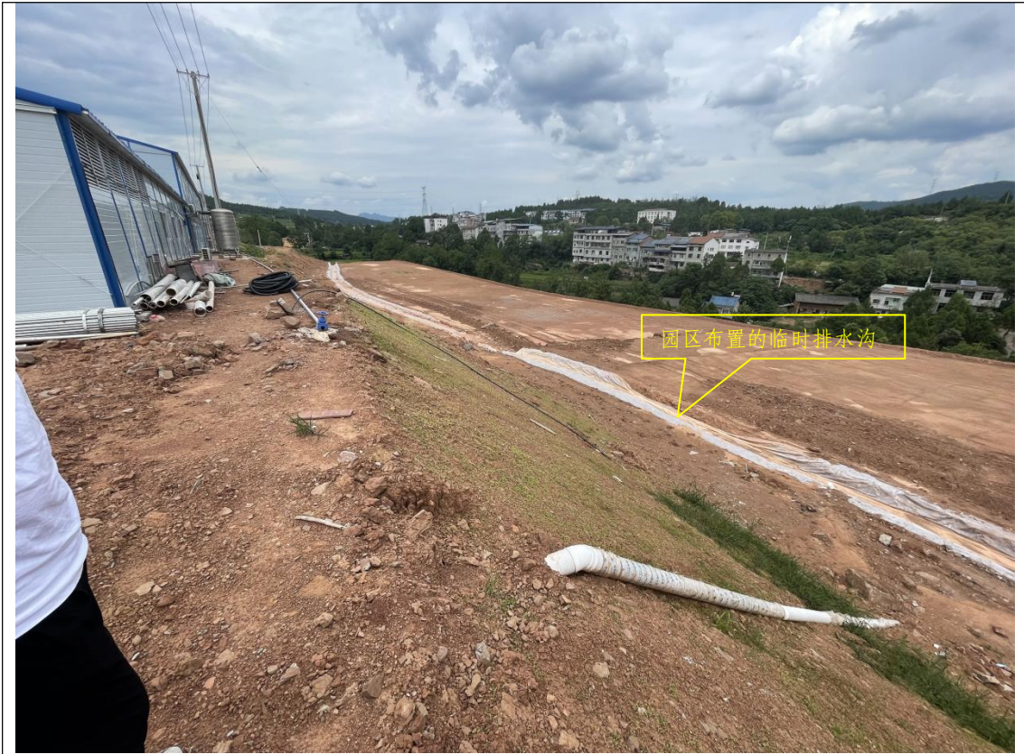
10、项目东侧外部现状
