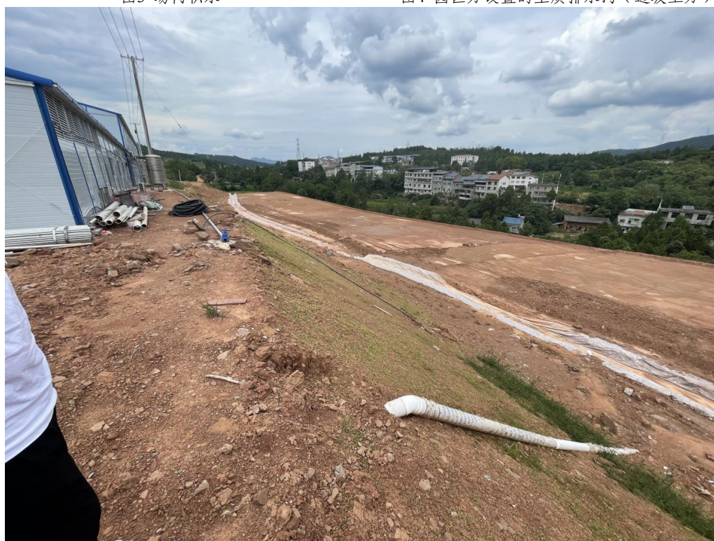
图5 园区方设置的土质排水沟（边坡下方）
