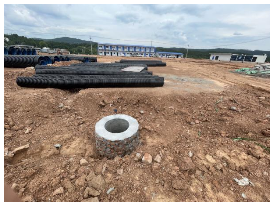
图2 已布置完成的雨水管及雨水井
