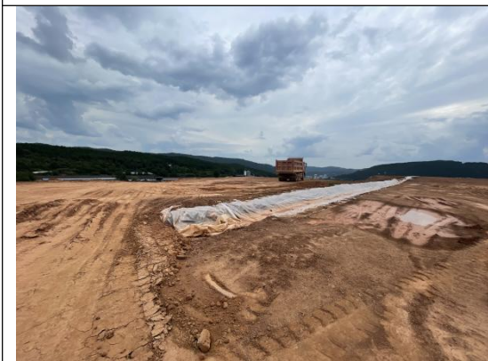
6、园区布置的临时排水沟
