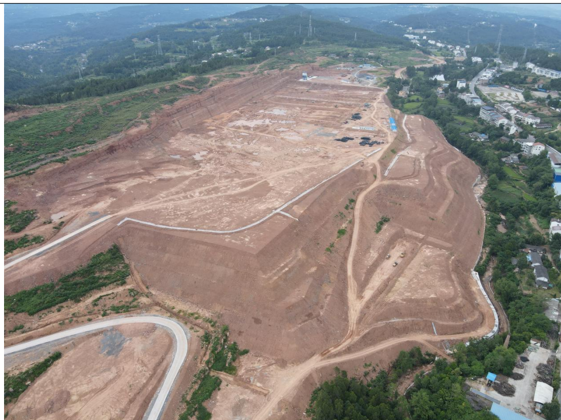
1 项目全貌（南侧拍摄）
