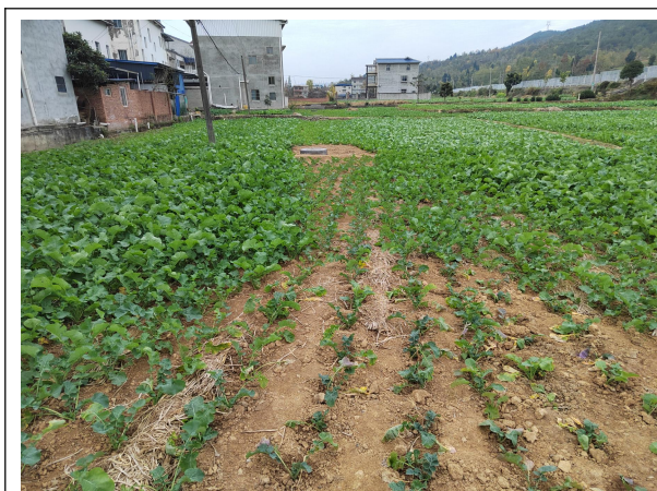
已完成管网敷设
