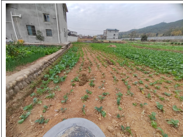
已完成管网敷设
