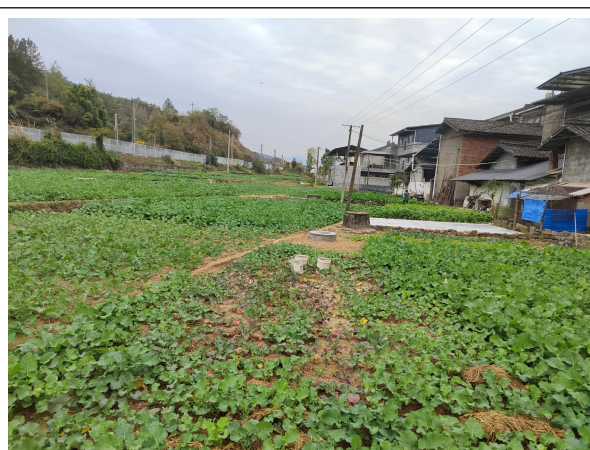
已完成管网敷设
