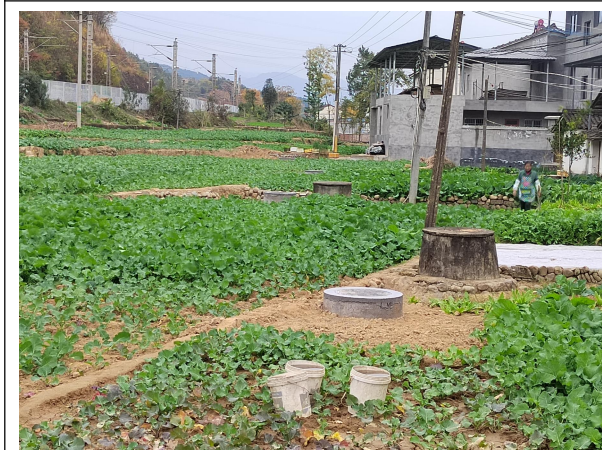
已完成管网敷设
