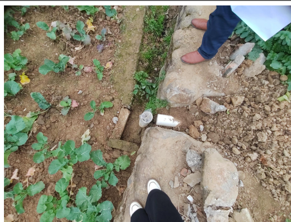
已完成管网敷设
