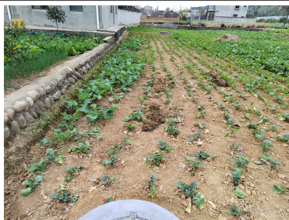
已完成管网敷设
