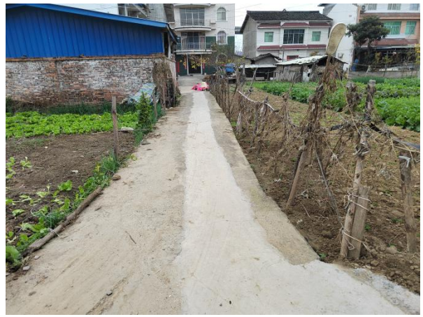
入户支管网（混凝土路面）
