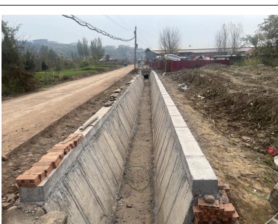
管沟施工现状
