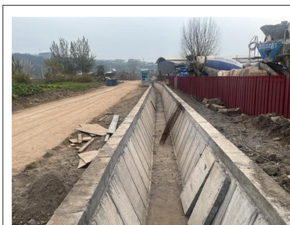
管沟施工现状
