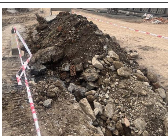
管沟施工现状
