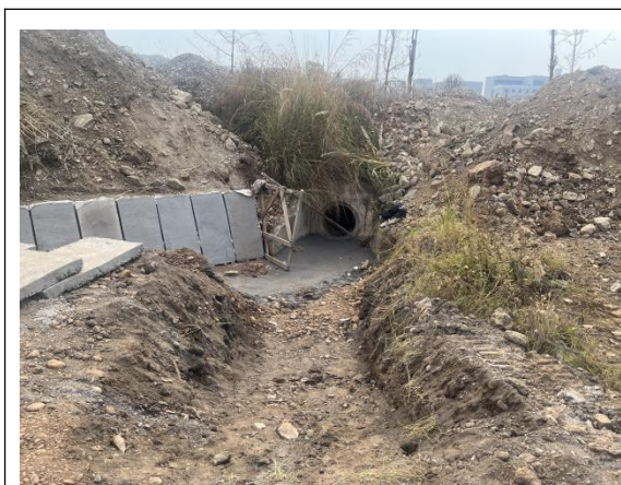
管沟施工现状
