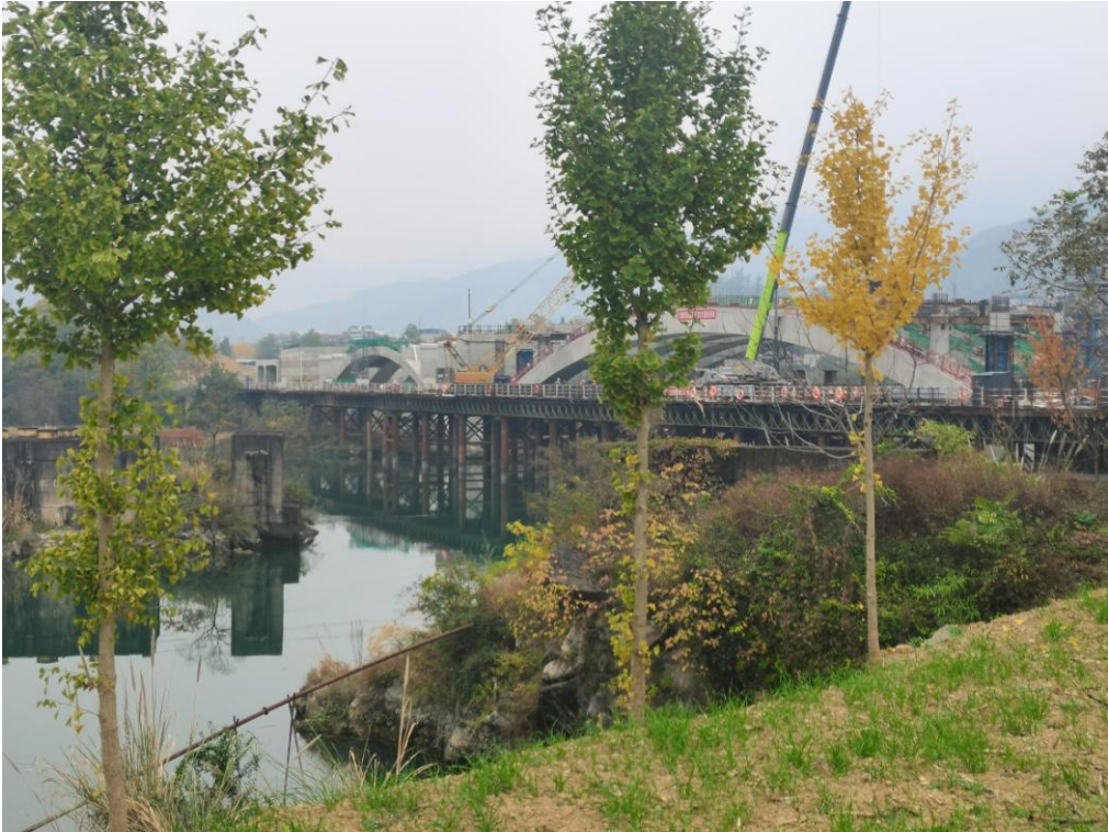
桥梁工程施工现状
