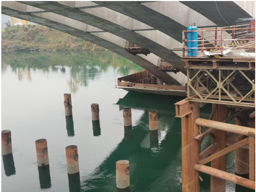
桥墩处还未拆除钢板桩围堰
