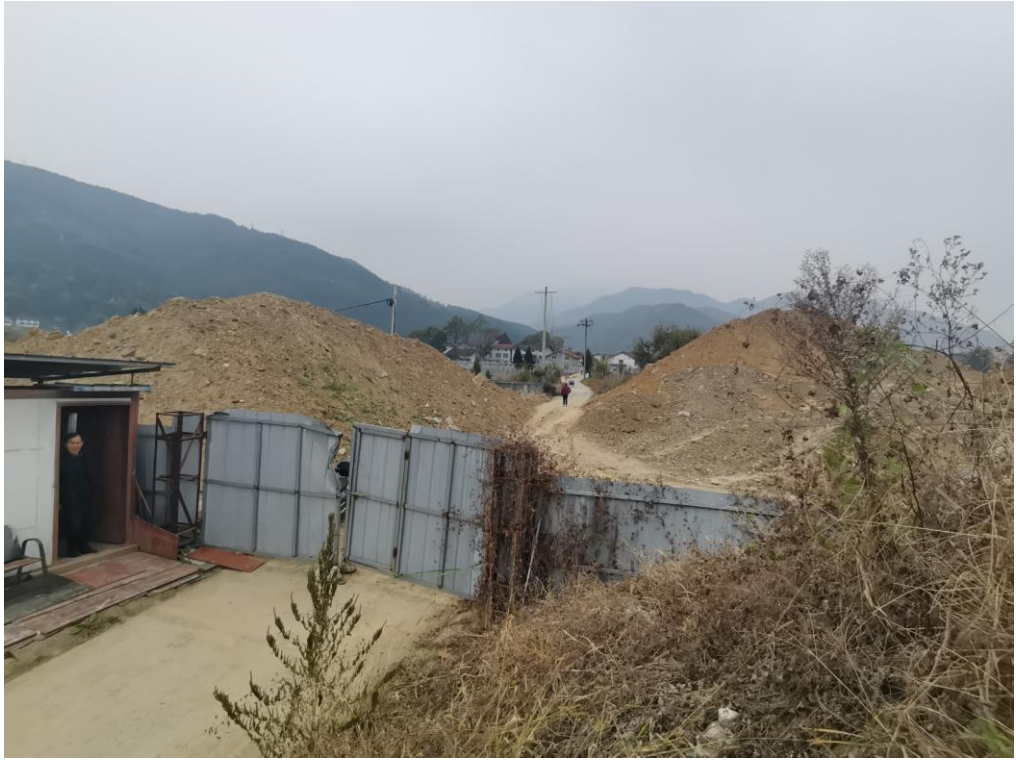
临时堆土区现状
