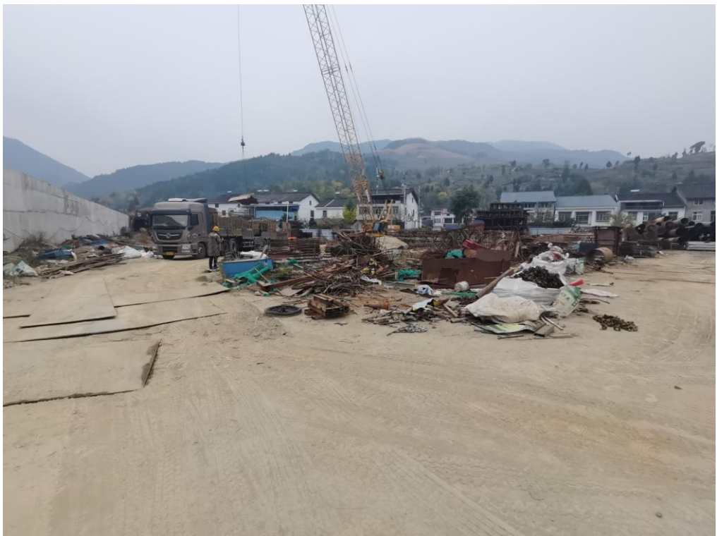
施工场地现状
