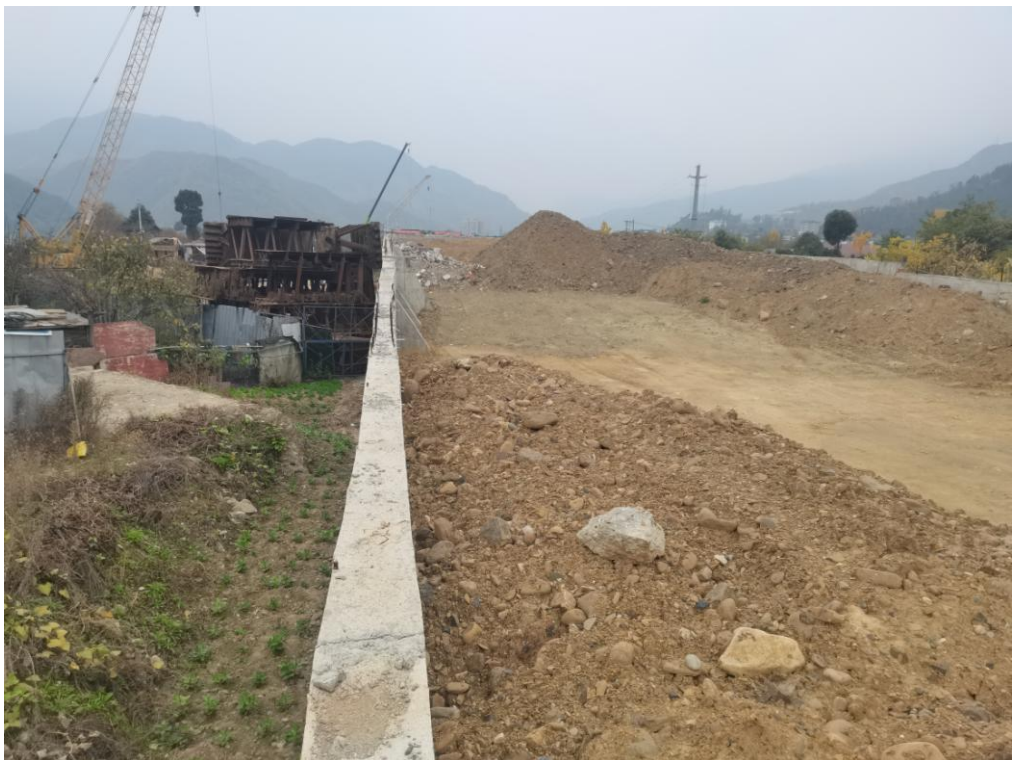
右岸引道现状
