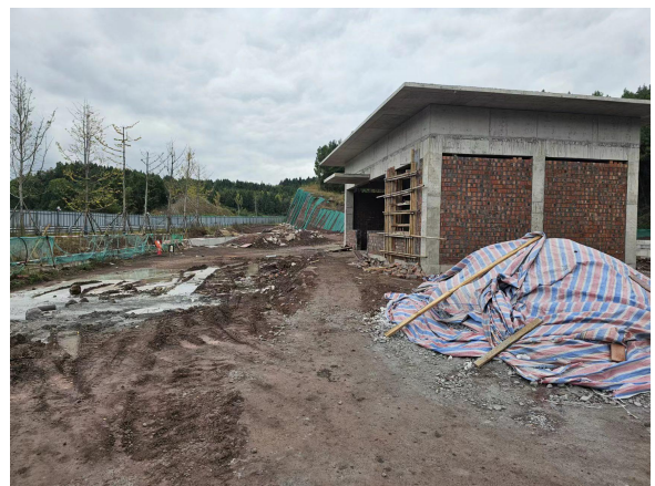
项目临时遮盖
