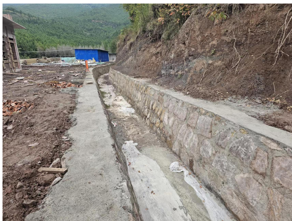
项目区两侧原有排洪沟
