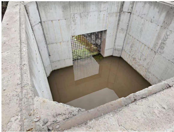
项目新建沉沙池
