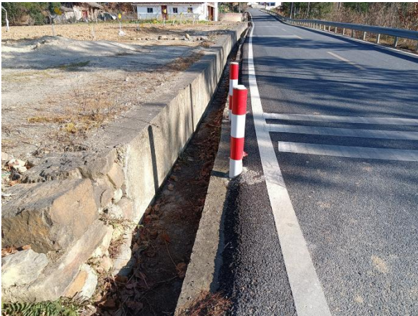
道路边沟现状
