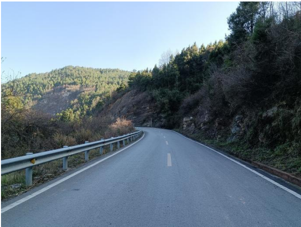
未施工路段现状（改造点3）
