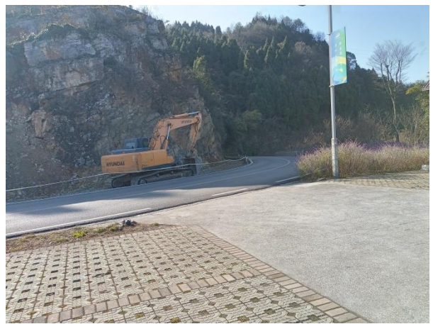
施工路段现状（改造点5）
