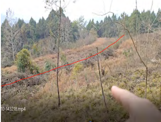
南侧边坡、挡墙、排水沟现状照片
