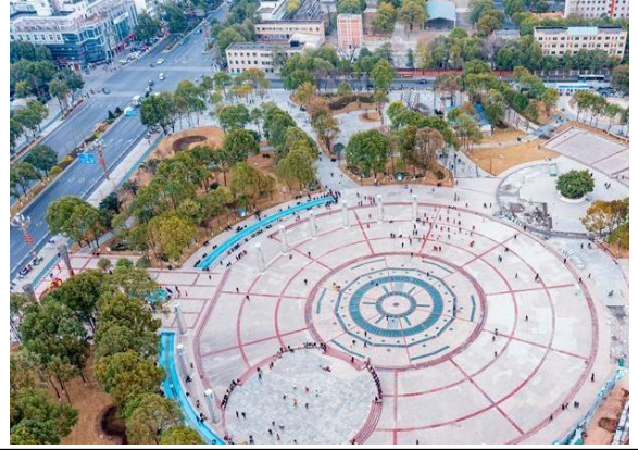
项目现状（基本完工）
