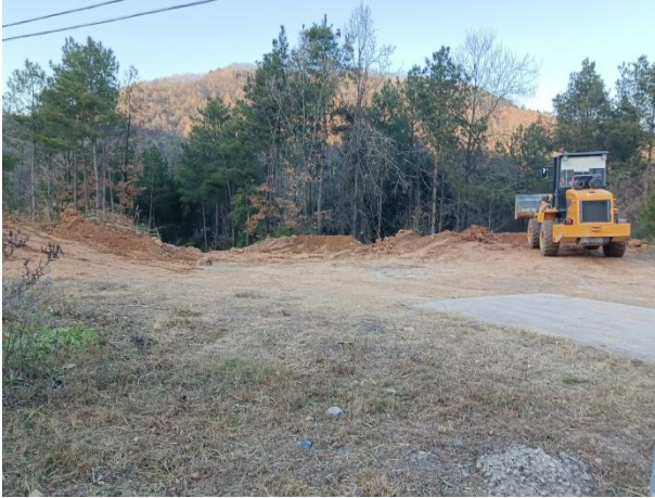
回填路段（改造点 f）
