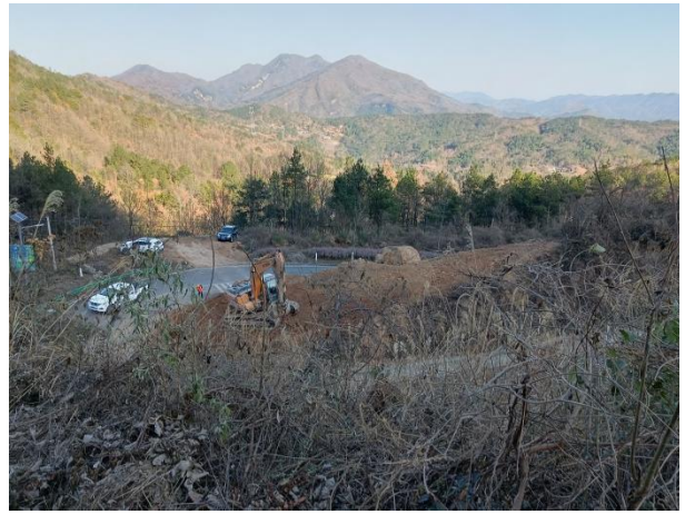
施工路段现状（改造点 g）
