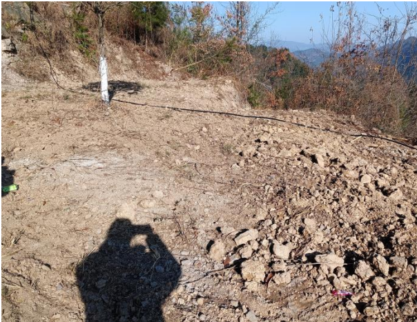
未施工路段（空地）
