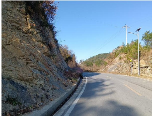
原有道路排水沟
