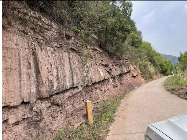
更换段2沿线情况2
