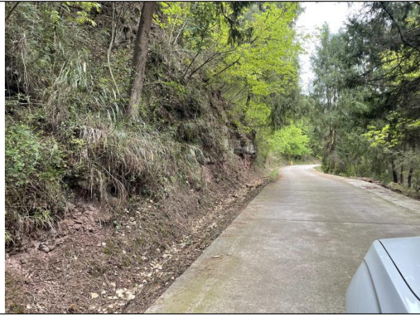
更换段1沿线情况
