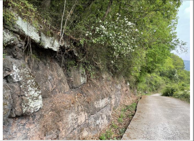
更换段2沿线情况1
