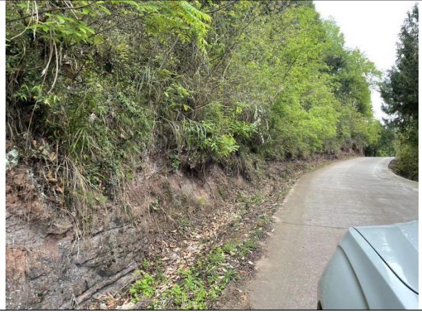
更换段1沿线情况
