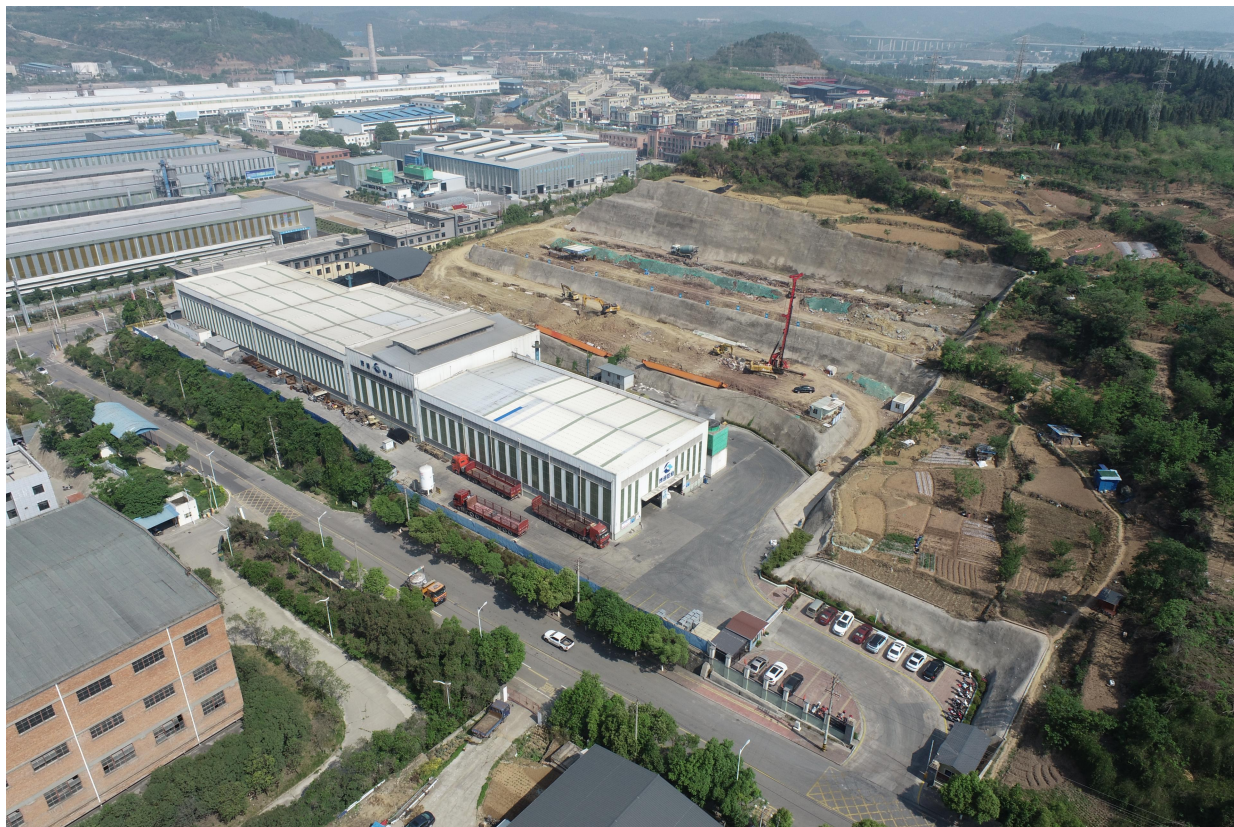
现场现状及周边状况（拍摄时间 2024.5）
