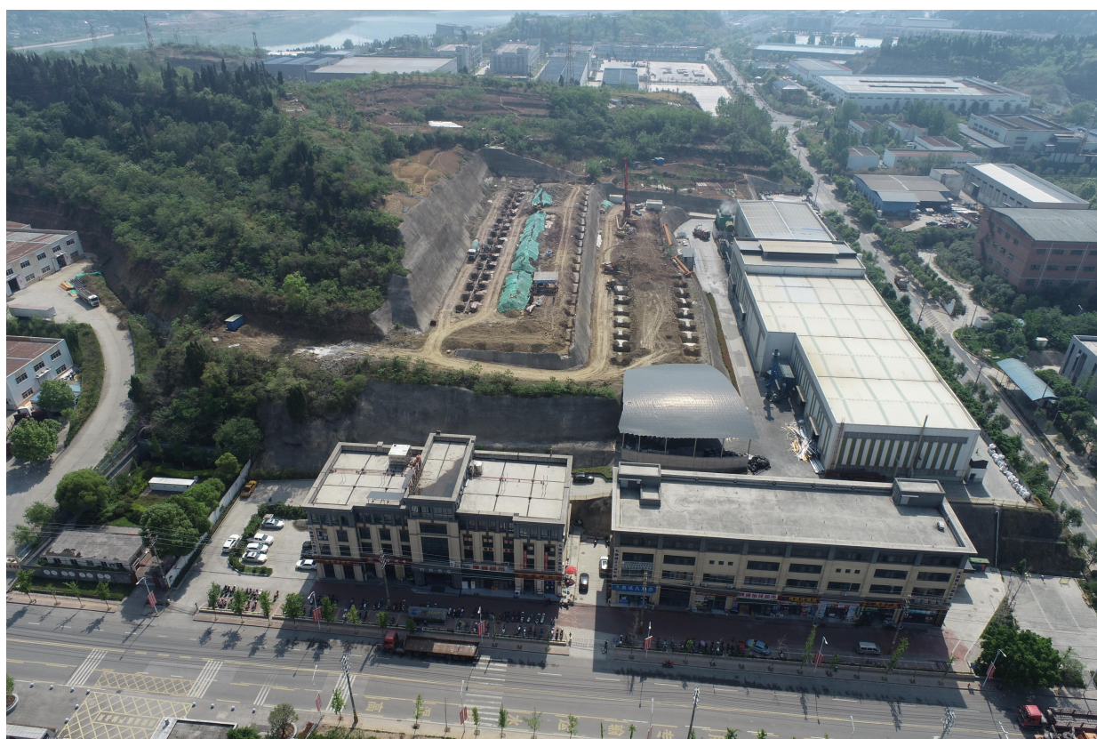
现场现状及周边状况（拍摄时间 2024.5）
