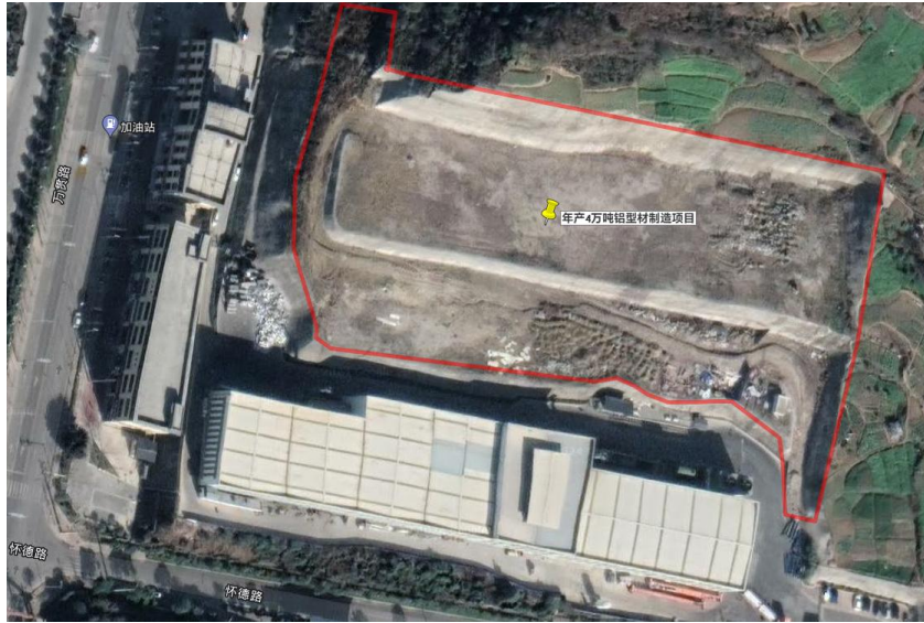
图 2.4-1 项目地貌现状图
