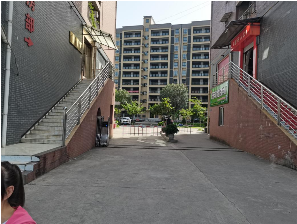
小区西侧出入口现状
