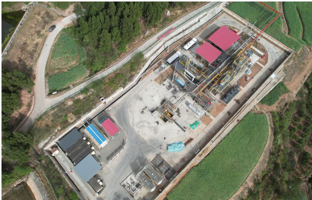
图 2.1-14 龙岗 062-X3 井现状照片
