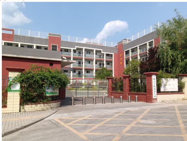
学校现状入口 2（南侧）
