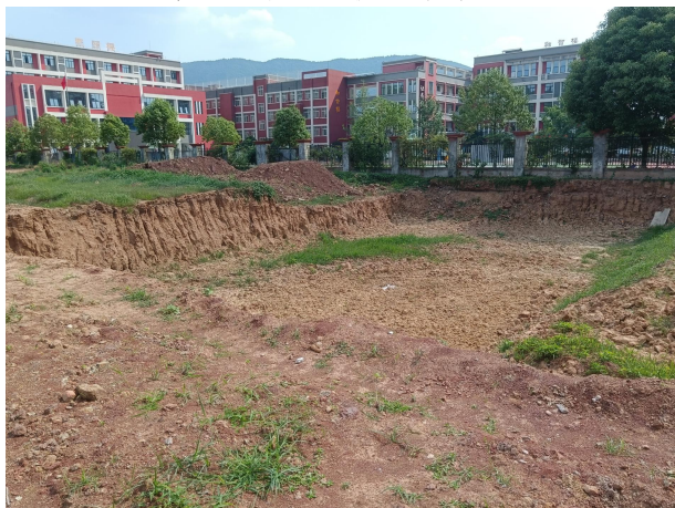
基坑开挖现状
