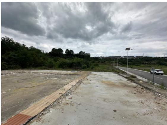
项目西北侧硬化地面现状
