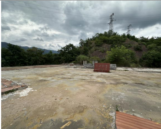
项目西北侧硬化地面现状
