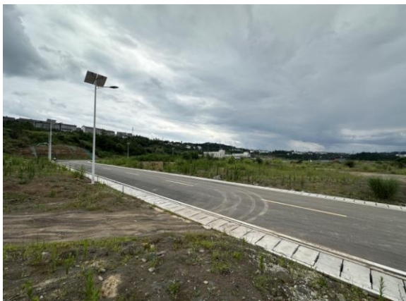
项目西侧园区道路现状
