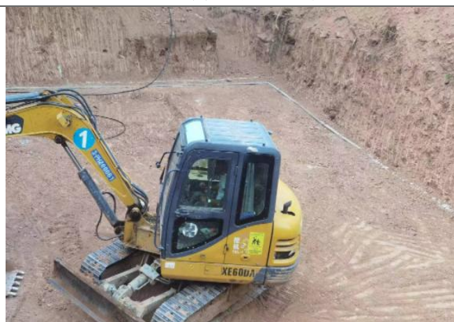
雨水蓄水池施工现状
