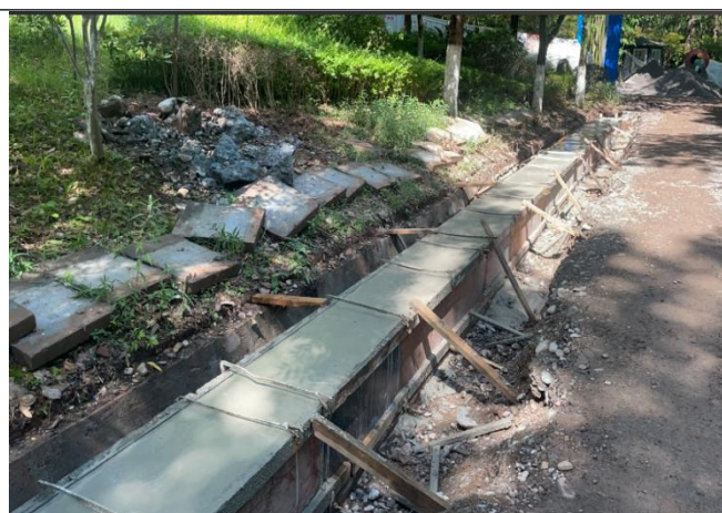
混凝土截水沟施工现状
