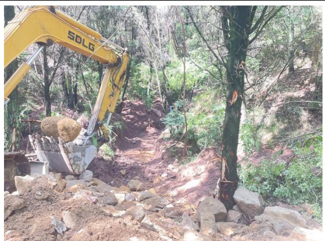
生态草沟施工现状
