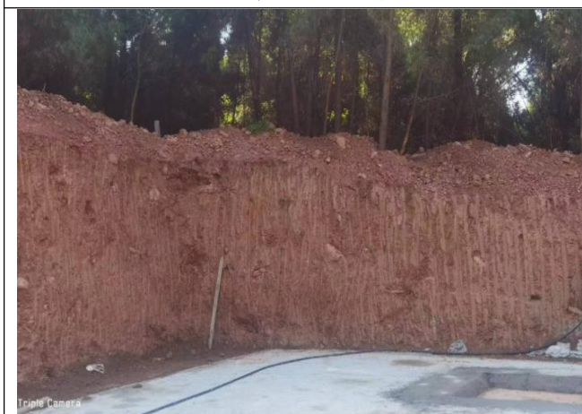
雨水蓄水池施工现状
