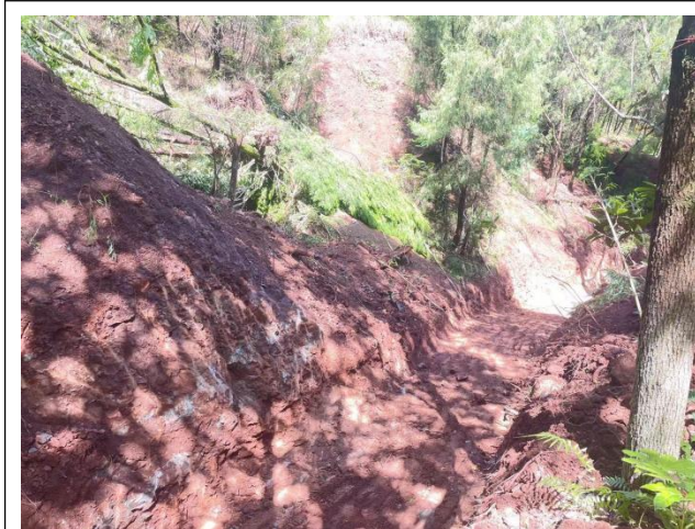
生态草沟施工现状
