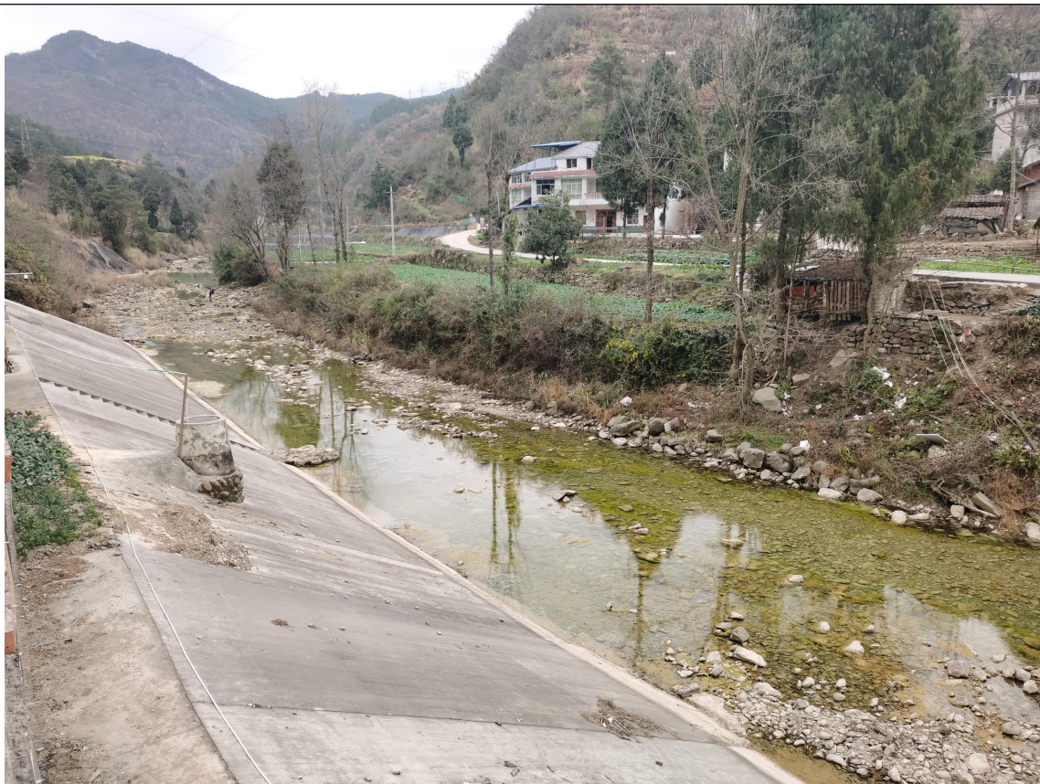
防洪堤现场照片
