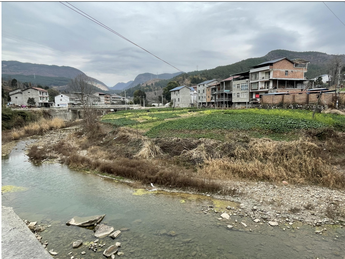
防洪堤现场照片
