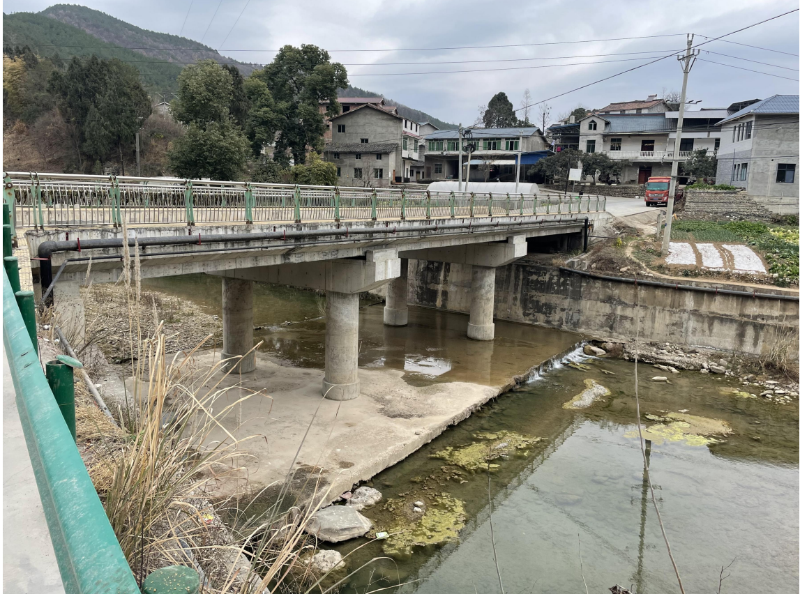
防洪堤现场照片
