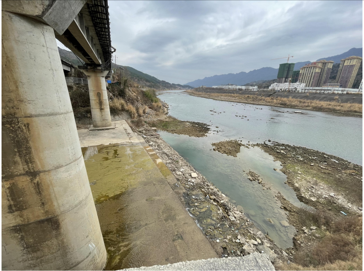
防洪堤现场照片
