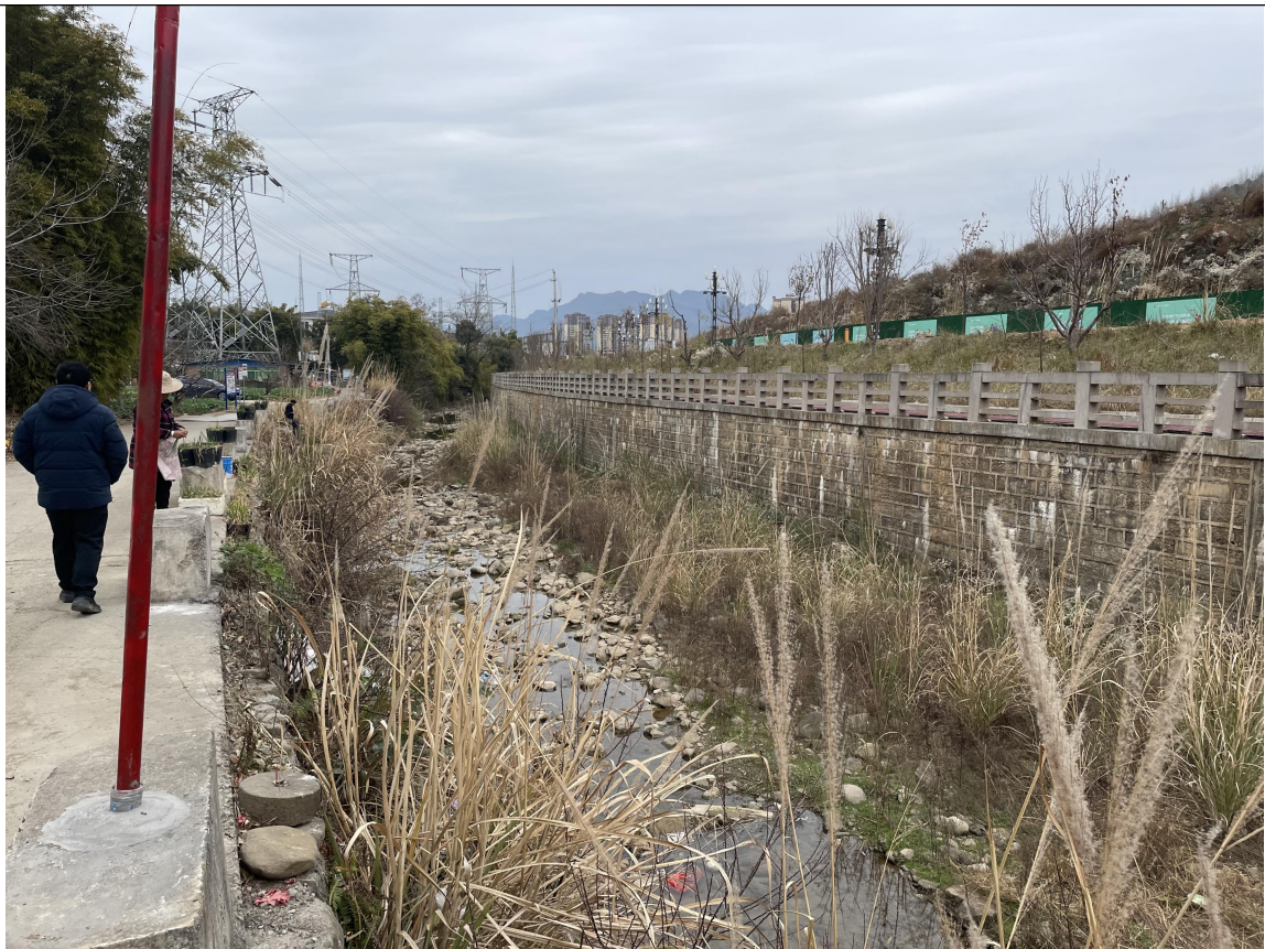
防洪堤现场照片
