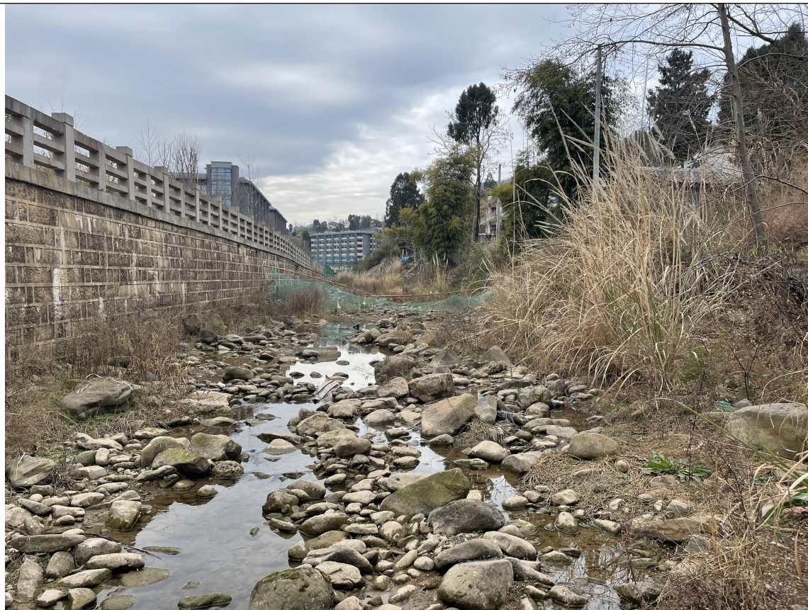
防洪堤现场照片
