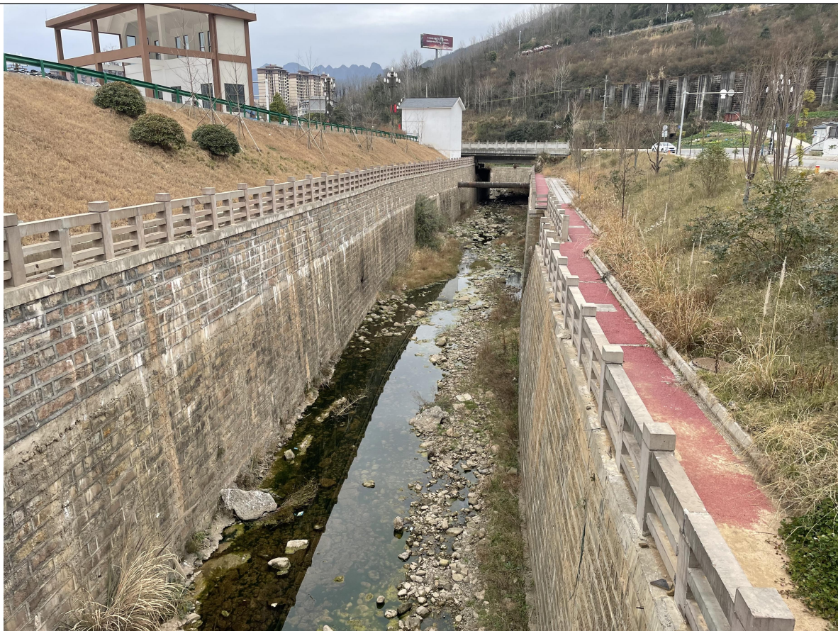
防洪堤现场照片
