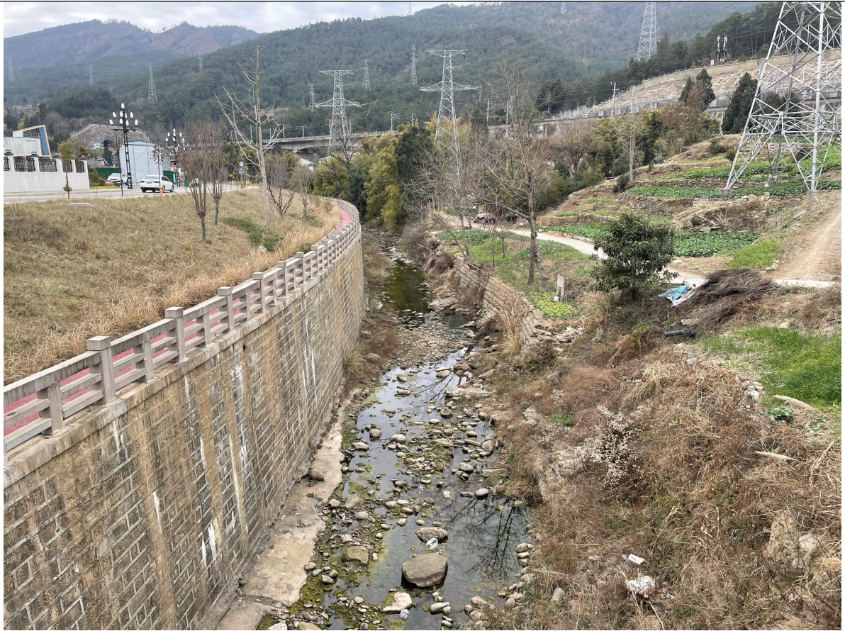
防洪堤现场照片
