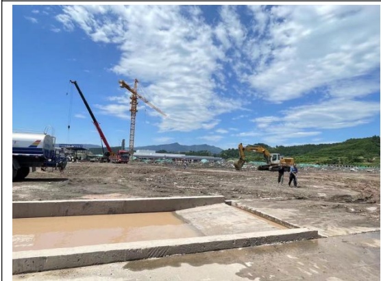
场地南侧现状
