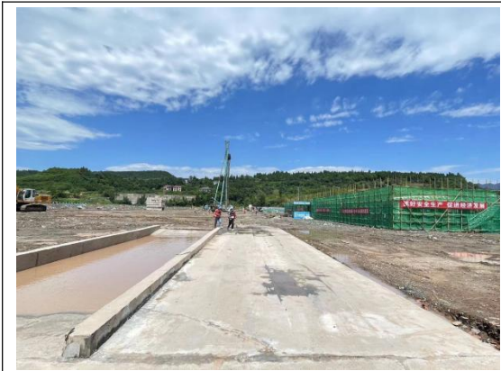
施工场地出入口（东侧）现状
