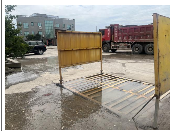
场地东侧出入口洗车槽
