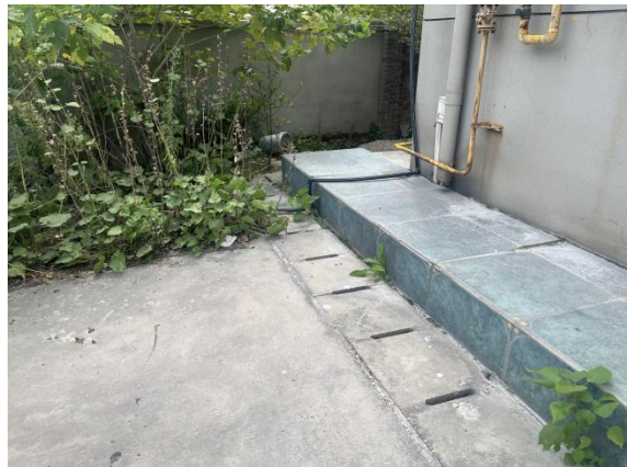
场地盖板排水沟
