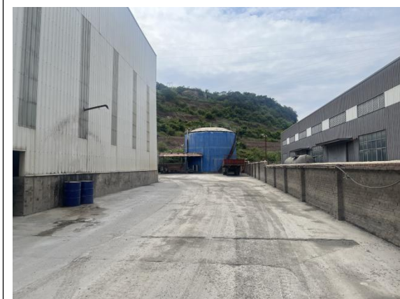
场地道路硬化区
