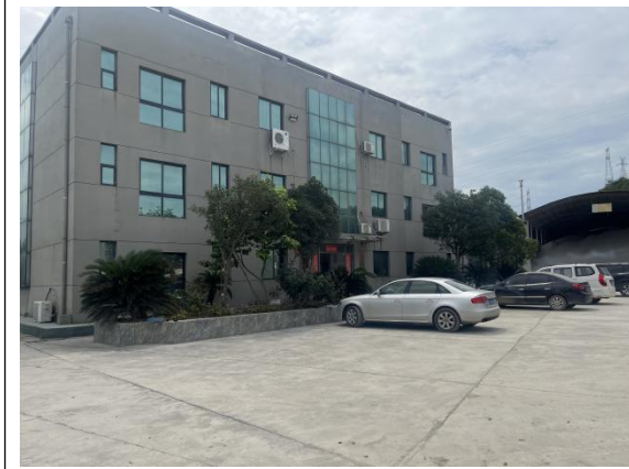
场地南侧办公楼
