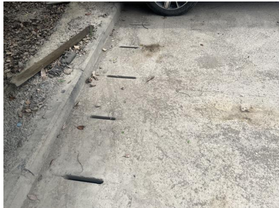
场地盖板排水沟现状
